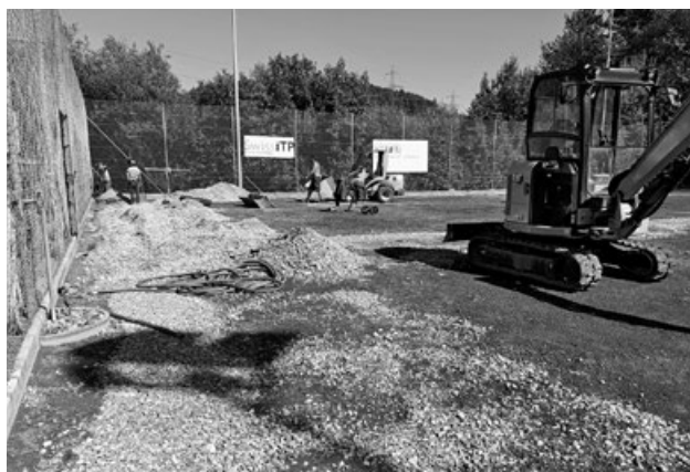
Der Sand der 36-jährigen Plätze ist entfernt, die erste Schicht Kies wird verteilt.
