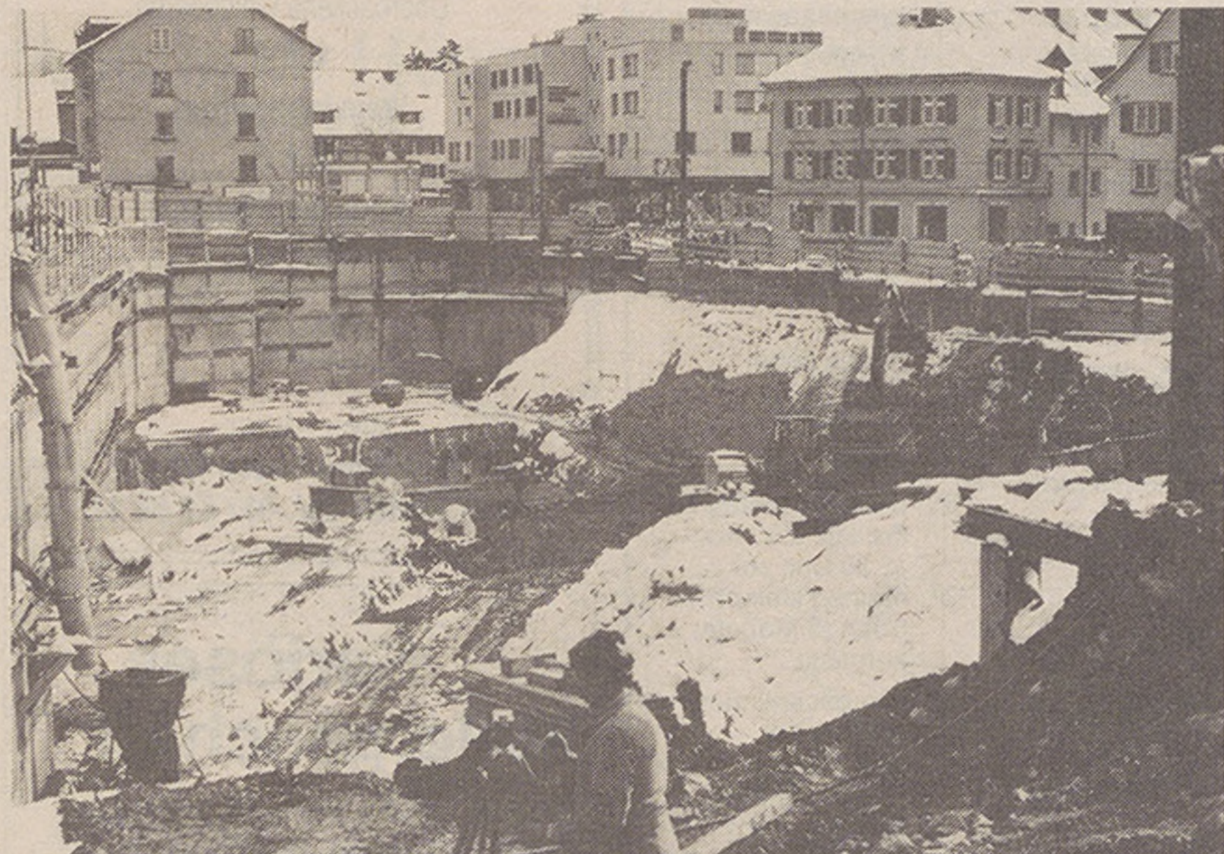
Blick auf die imposante Baugrube des Hönegger Marktes von der Regensdorferstrasse Richtung Meierhofplatz.
