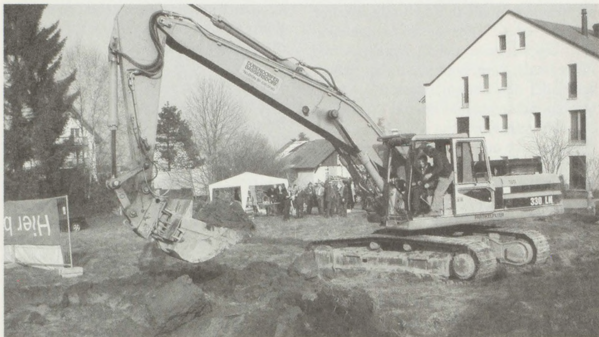
Statt des bisher üblichen Spatenstichs hob der Bagger – mit Peter Oser, dem Präsidenten der Gewo, am Steuer – die erste Bodenkrume ab. {Foto: go}
