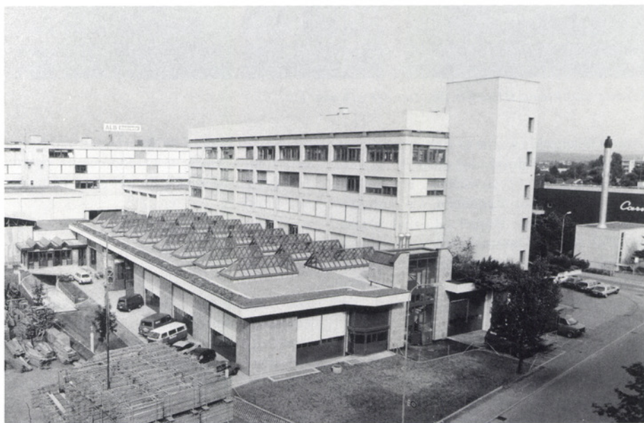
Eine neue, nach modernsten Gesichtspunkten konzipierte Fabrikations- und Montagehalle nahm die Fässler AG in der zweiten Hälfte 1987 in Betrieb.
