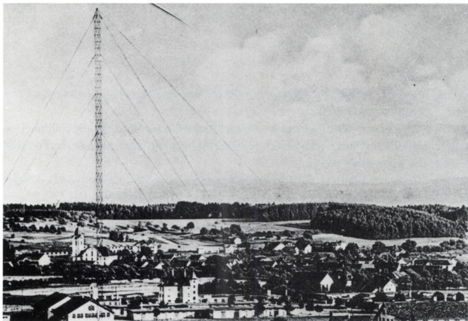
Vor der Kulisse des noch dünn besiedelten Dorfes Kloten stellte man im Jahre 1921 den 122 Meter hohen Sendemast auf.
