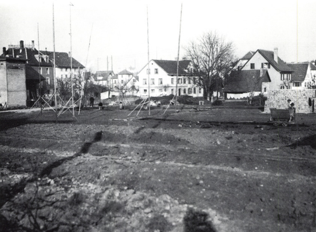
Bauplatz Dorfschulhaus B: Blick Richtung Bahnhofstrasse und Strehlgasse.
