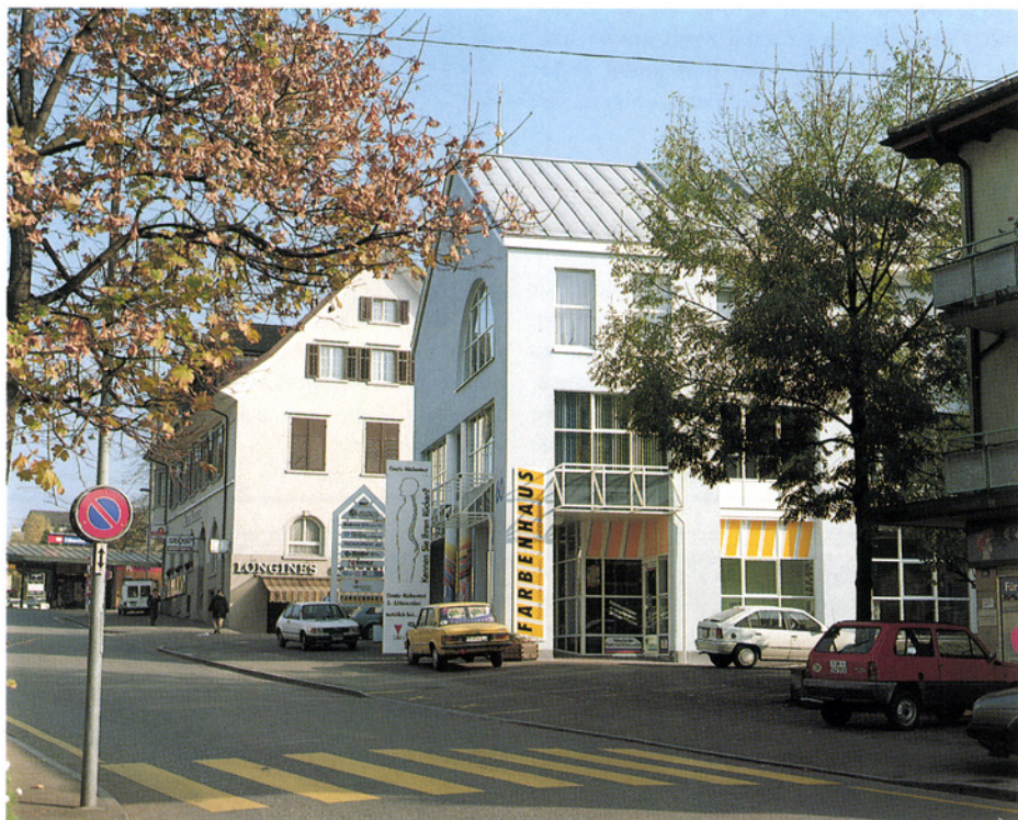
Die etwas eigenwillige moderne Architektur des neuen Geschäftshauses Bahnhofstrasse 60 beeinflusst das Erscheinungsbild des Bahnhofquartiers nachhaltig positiv.
