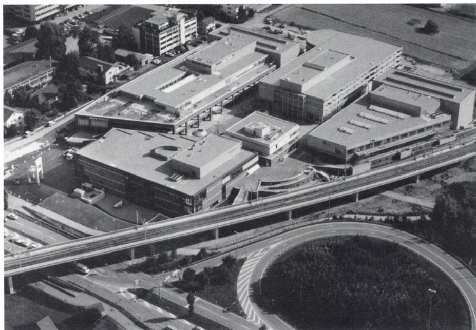
Luftaufnahme des in zweijähriger Bauzeit errichteten «Wohnlandes» von Möbel Pfister im Hochbord.
