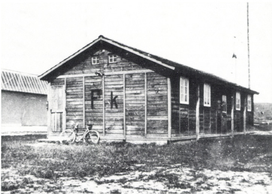
Die 1919 als Holzbaracke erstellte erste Funkstation Dübendorf stand am östlichen Ende des damaligen Flugplatzareals.
