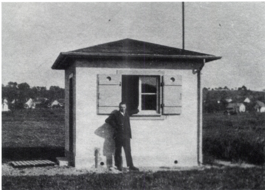
Die 1926 aufgestellte Peilstation stand etwa 300 m nordöstlich der neuen Funkstation.
