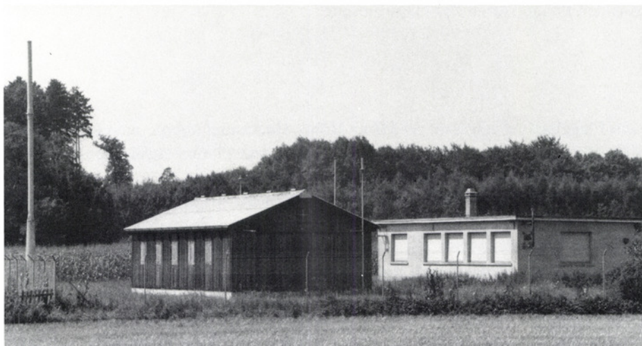
Die «neue» Peilstation Dübendorf von 1936, wie man sie heute noch sehen kann (Gebäude rechts).
