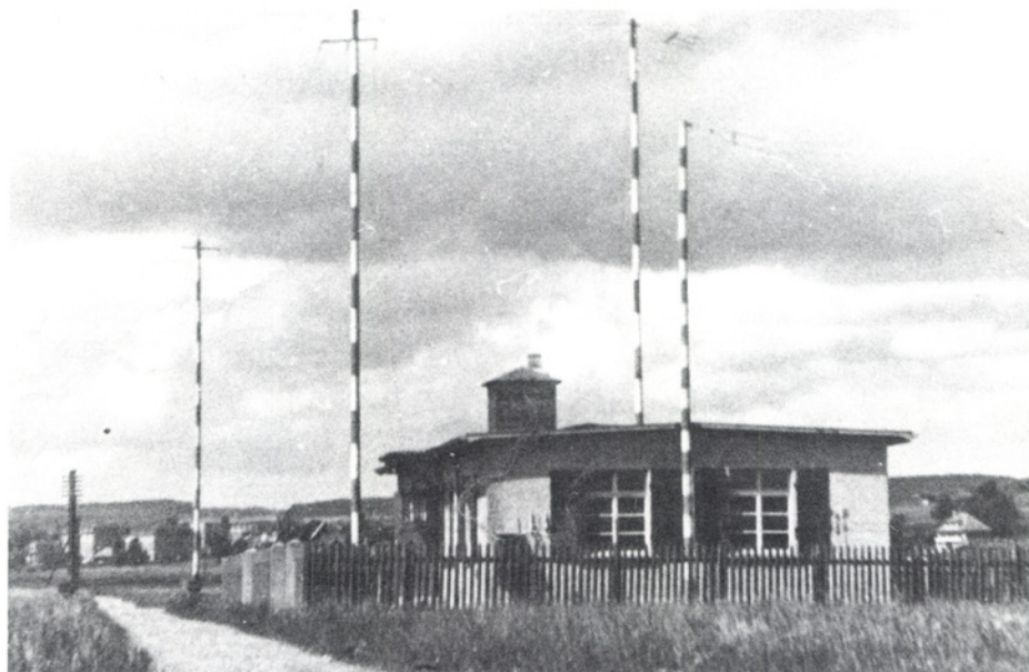
Das 1925 erstellte Funkhaus in den Wechselwiesen am Fussweg nach Brüttisellen.
