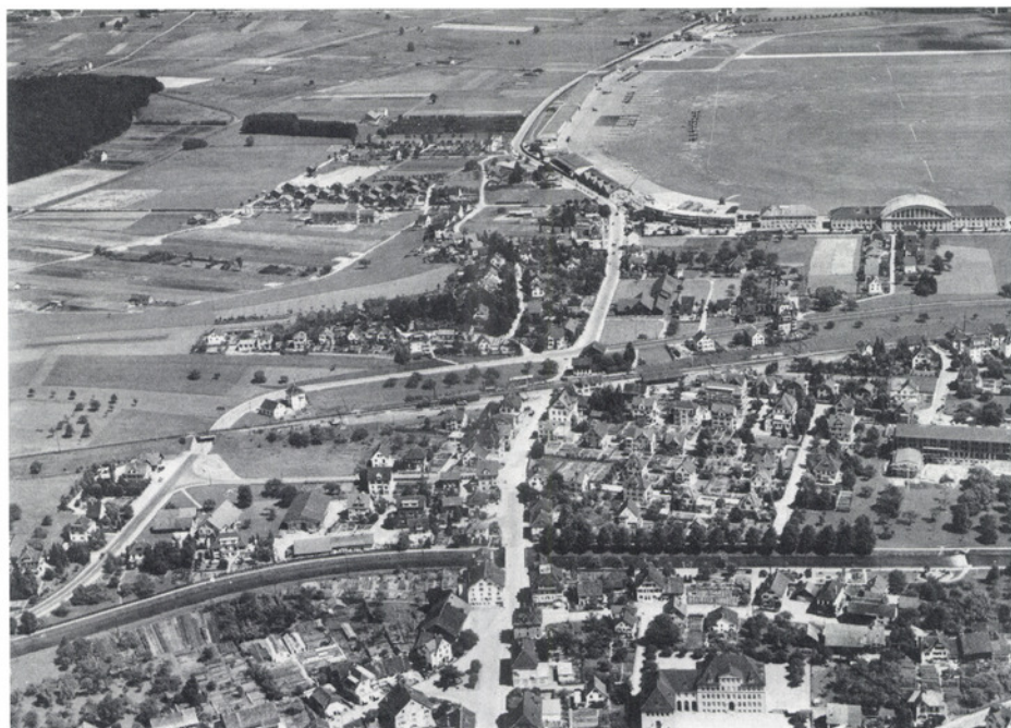
Dübendorf 1939: Noch ist das Gebiet zwischen Bahnhof und Militärflugplatz wenig überbaut und im Unterried steht die Aspirantenkaserne noch im Bau.
