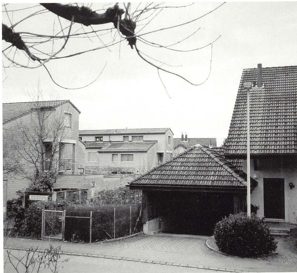
Hier stossen die beiden Siedlungsformen Sichtbacksteinhäuser (links) und Krüppelwalmdächer (rechts) aufeinander.
