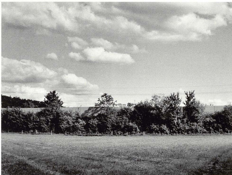
...mit der Lärmschutzwand auf der andern Seite.
