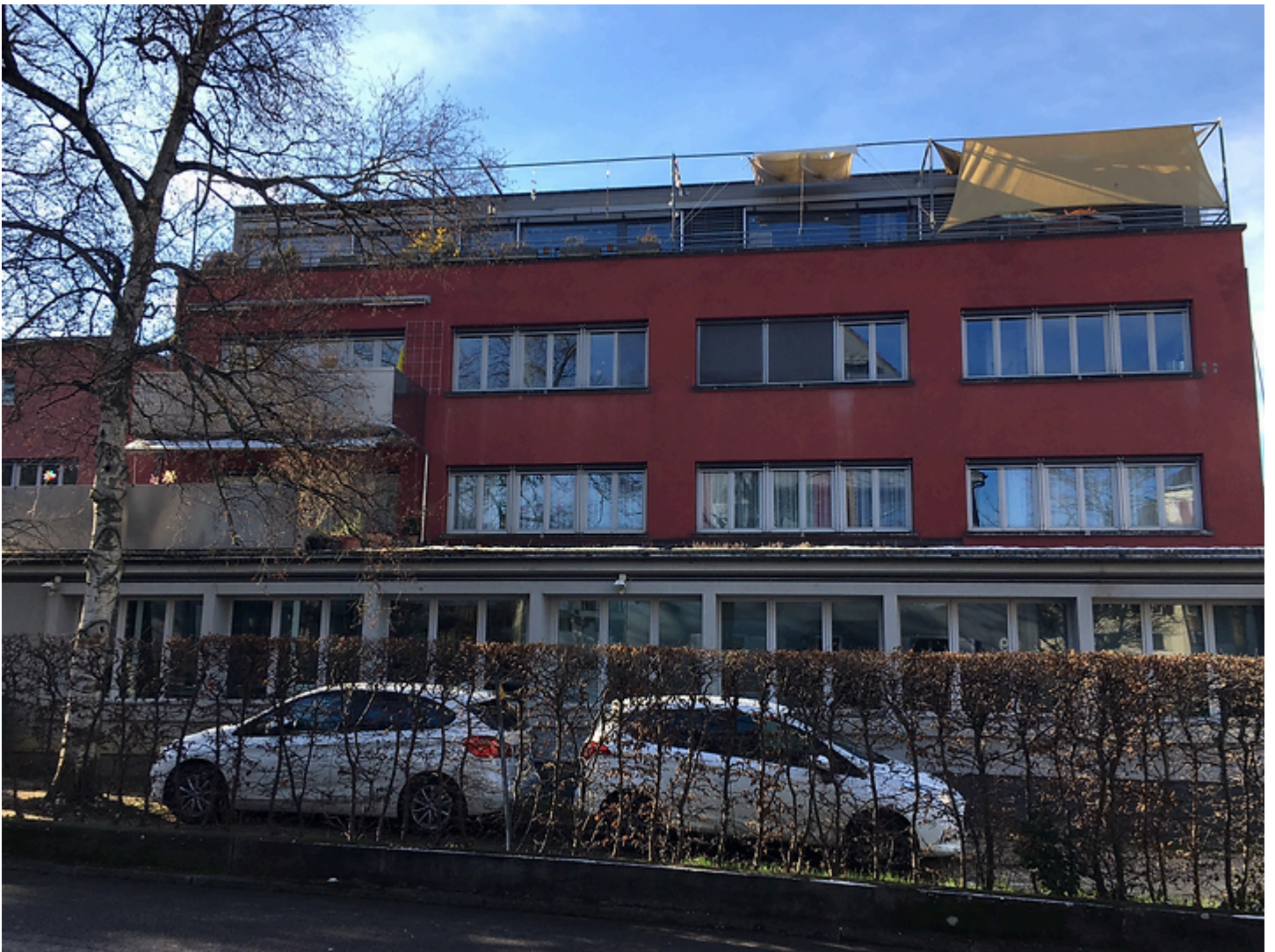
Nidelbadstrasse 6/8. Ehemaliges Fabrikgebäude Henry Weber Tabak. Baujahr 1932. Foto: SB (19.1.2023) Heute Wohnkomplex der Stiftung PWG.
