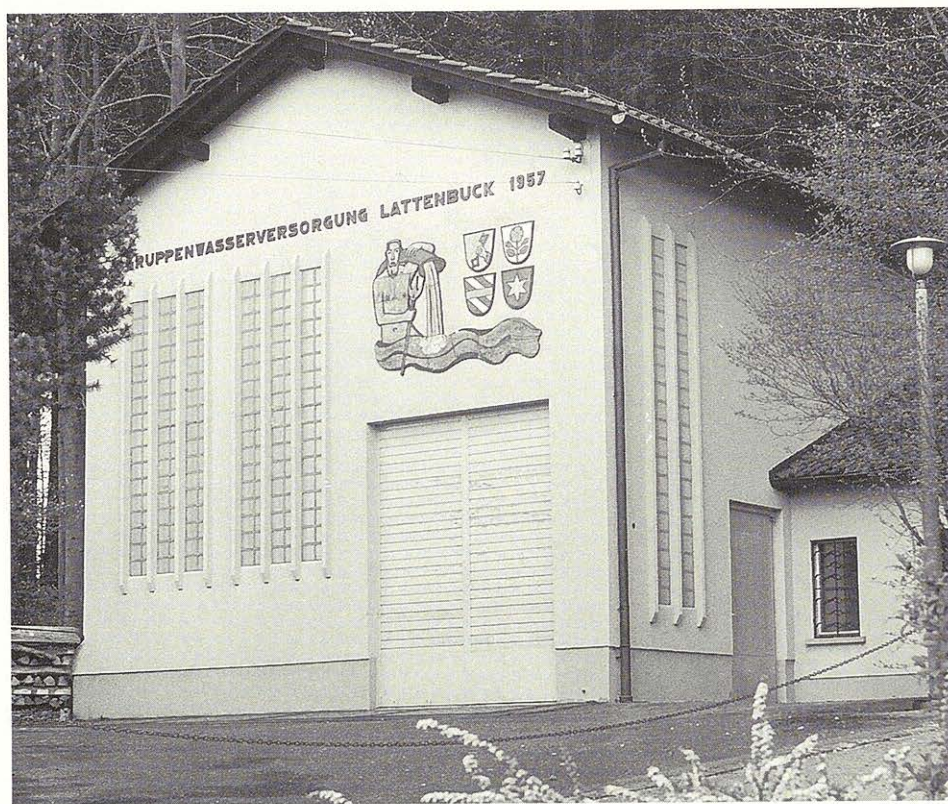
Das Grundwasserpumpwerk Büel beim Beginn des Vita-Parcours in Brüttisellen ist eines der grössten der Gruppenwasserversorgung Lattenbuck. Es hat eine Förderkonzession von 9000 l/Min.
