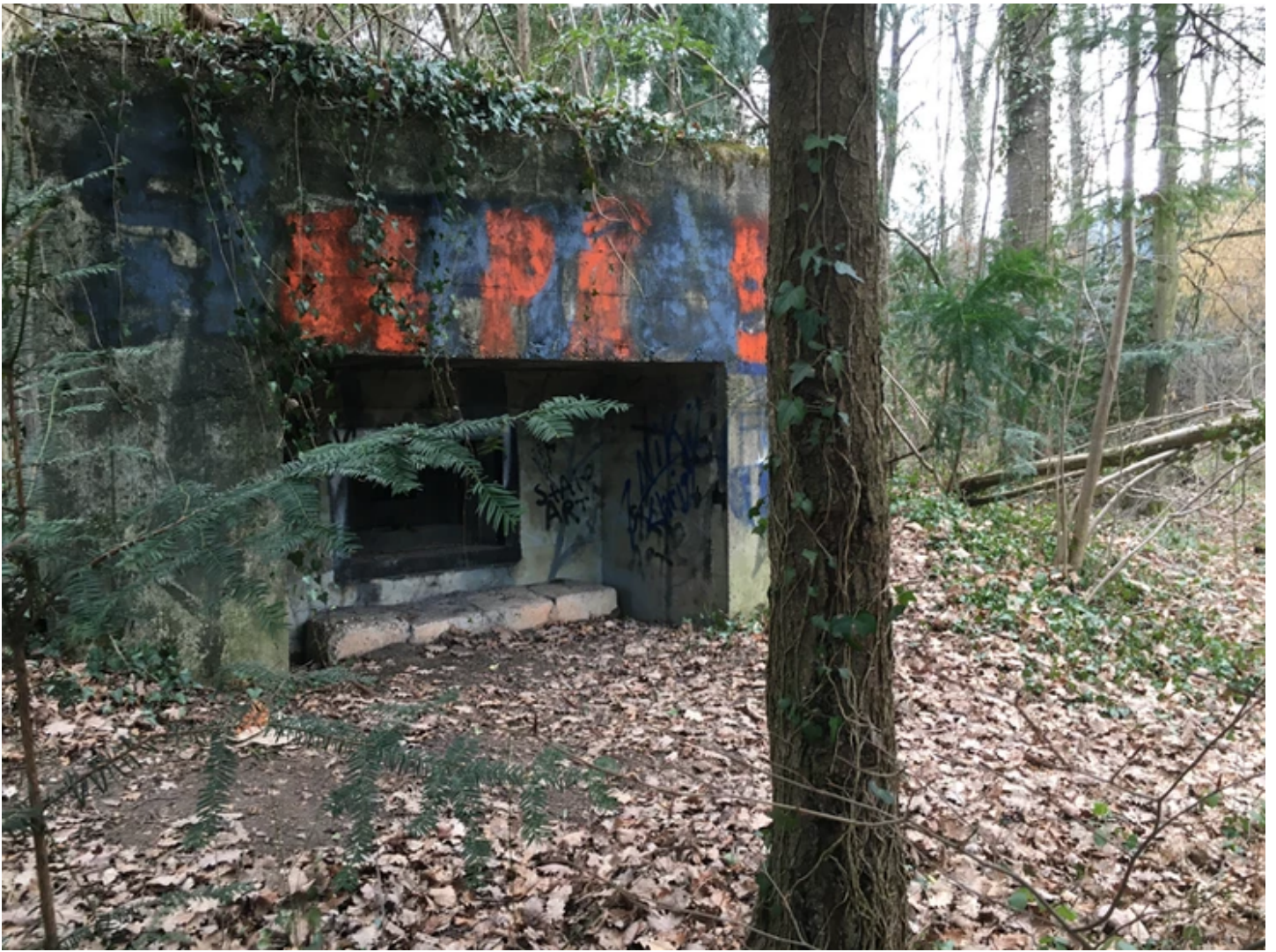
Bunker im Entlisbergwald. Foto: SB (27.2.2021).
