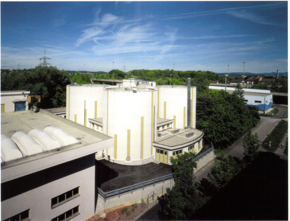
Blick vom Geschäftshaus der DEC Digital Equipment Corporation AG auf das Filtrationsgebäude, die Faultürme mit Betriebsgebäude und die Schlamm-trocknungshalle (rechts).
