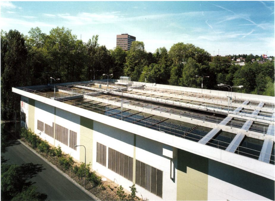
Blick auf den zweistöckigen Biologieblock mit den Belüftungsbecken im Erdgeschoss und den Nachklärbecken im Obergeschoss.
