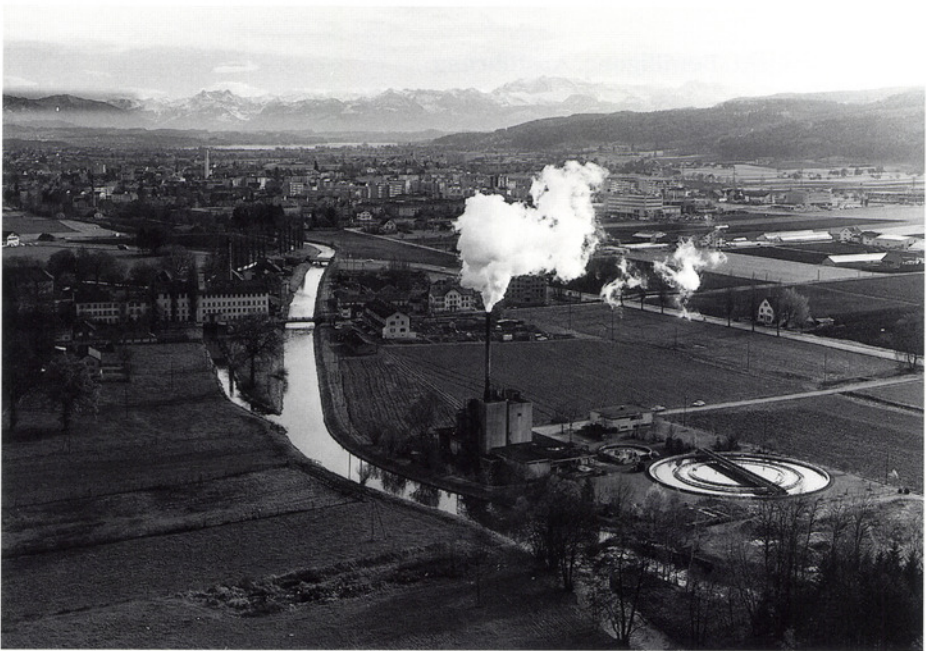
Luftaufnahme von 1967 mit alter Kläranlage und ehemaliger Kehrichtverbrennungsanlage. Die Kapazität der 1964 errichteten Kläranlage war nach 25 Betriebsjahren ausgelastet, und ein Ausbau wurde fällig.
