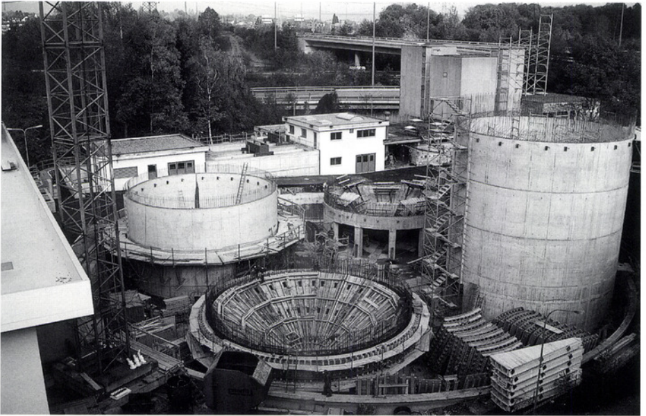
Bau der vier zur Schlammfäulung und Klärgasgewinnung dienenden Faultürme, die für ein Schlammvolumen von je 1400 Kubikmetern ausgelegt sind. In den Zwischenräumen ist das Betriebsgebäude entstanden.
