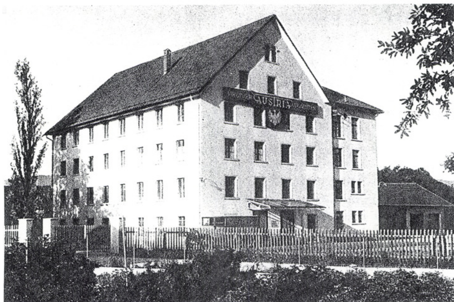
Das Gebäude der ehemaligen Baumwollspinnerei Hanhart, wie es sich nach der Übernahme durch die «Österreichische Tabak-Regie» präsentierte. Stolz blickt der Adler auf die neu erbaute Überlandstrasse herab, die damals noch «Autostrasse» hiess.
