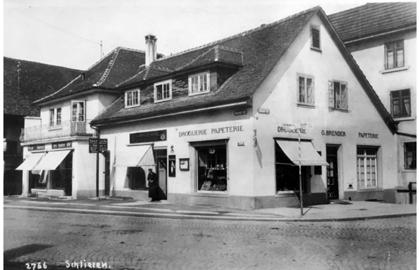
Geschäftsräume an der Badenerstrasse 1 (abgebrochen um 1970) neben der Drogerie Brender.
