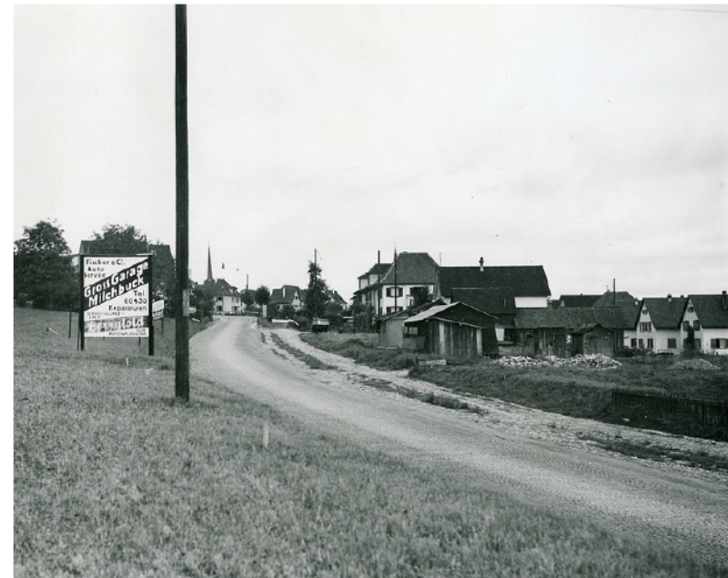
1936: Die Ueberlandstrasse vor ihrem Neubau (Bild: BAZ_134245)
