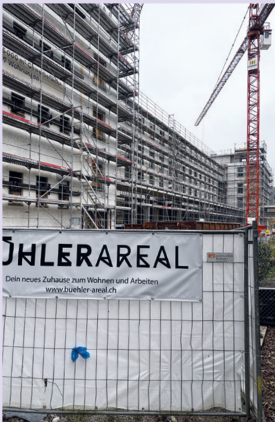
Ein ganzes Quartier entsteht. 87 Wohnungen sind im Bühler-Areal Mülau im Bau.
