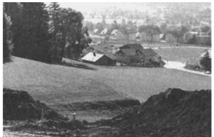
Der Schlittelhang im ungefähr verlangten Ausmass der Initiative des Ortsvereins. Die Photographie wurde im Herbst 1983 aufgenommen, als die Erdverschiebungen für die Florenstrasse gemacht wurden, von denen ein Teil im Vordergrund sichtbar ist.
