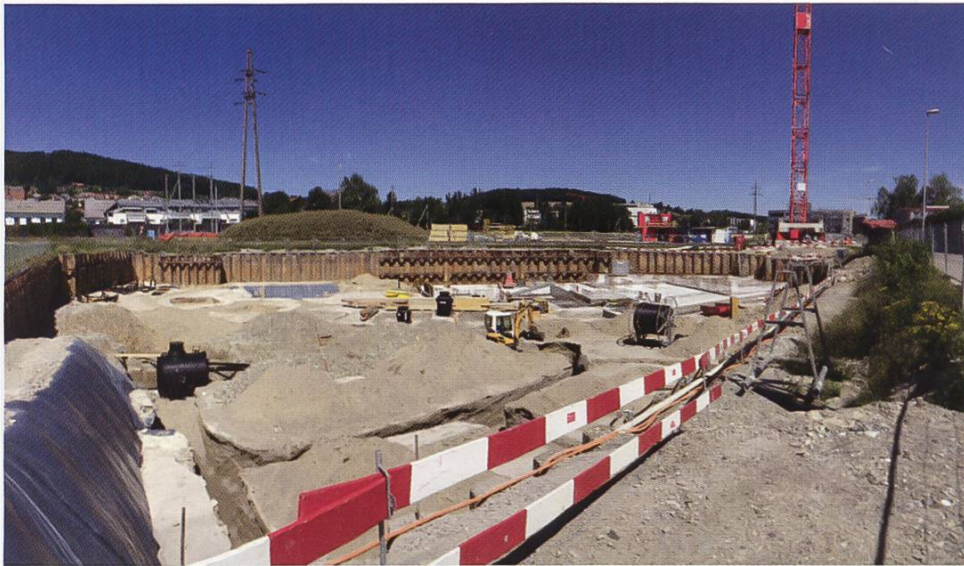
Die Baustelle der Seniorenresidenz Buchs im August 2017
