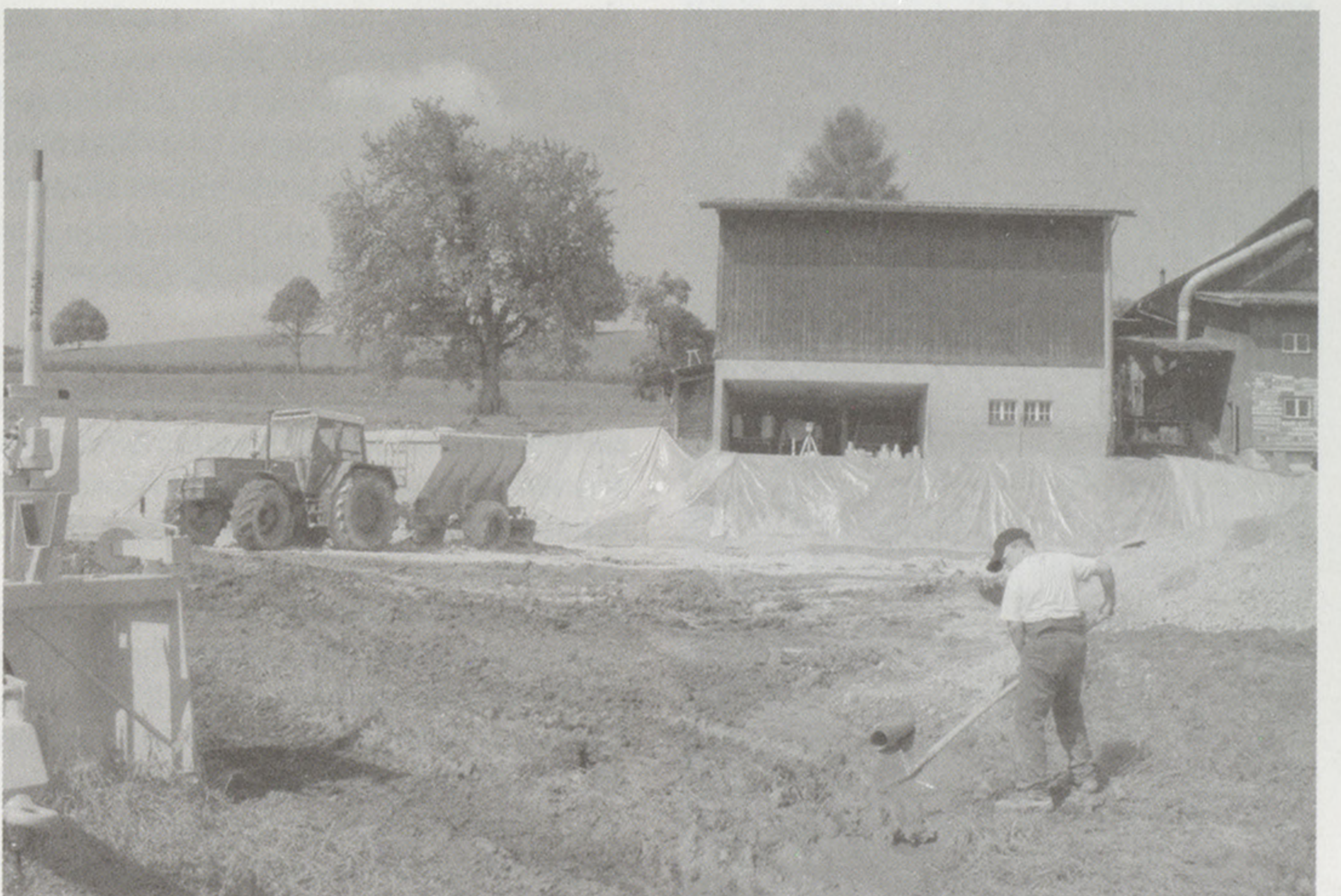
Baustelle ausgangs Ebmingen Richtung Maur: Hier entsteht keine Reithalle. Die Familie Bär baut dort einen tierfreundlichen Auslaufstall für ihre Zucht- und Concourspferde sowie für einige Pensionspferde. (Foto: sl)
