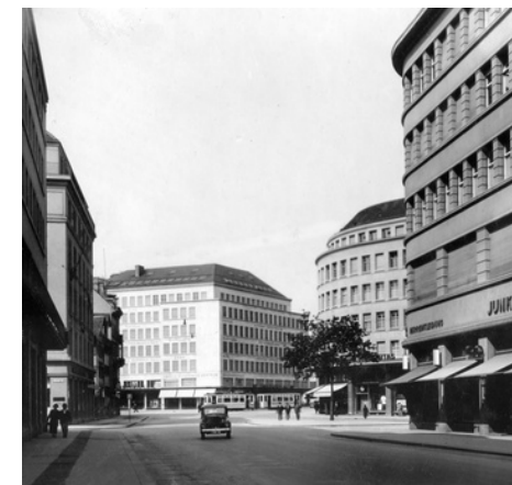
1934: Modernität an der Sihlporte (Foto: BAZ_078544)
