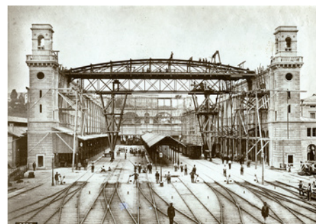
Der neue Hauptbahnhof im Bau 1867 (Foto: BAZ_098164)
