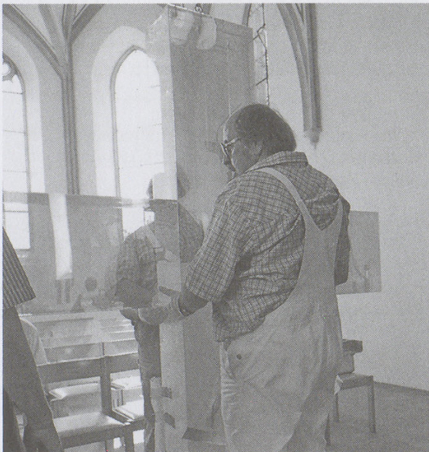
Ludger Hinse bei der Montage des Lichtkreuzes in der Kirche Maur.
