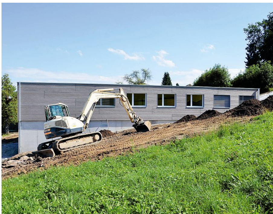
Das neue «Chinderhuus» in Ebmatingen wird pünktlich auf den Schulanfang fertig. Das Gebäude fügt sich optimal in den Hang ein. (Foto: sl)
