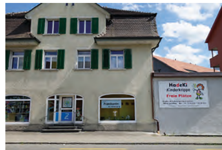
Die Kinderkrippe «HadeKi» an der Zürichstrasse 23 in Brüttisellen.
