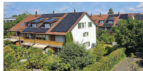
Neun Reiheneinfamilienhausbesitzer:innen haben 2023 an der Dorfstrasse 51 bis 69 in Brüttisellen eine PV-Anlage auf ihrem Dach montieren lassen.
