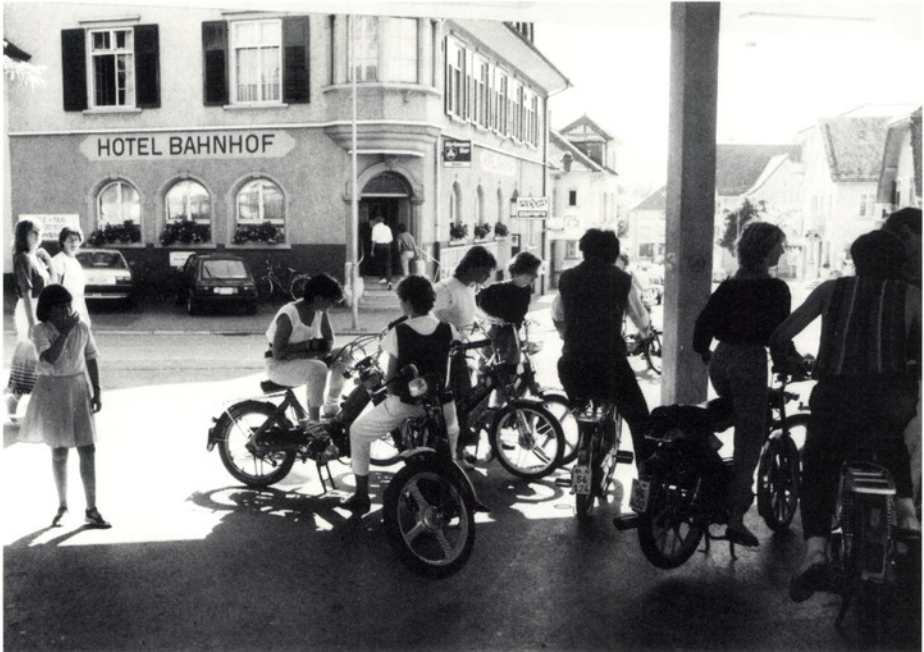
Das schützende Dach zwischen Kiosk und Treppe macht den Bahnhof oft zum Treffpunkt motorisierter Jugendlicher.
