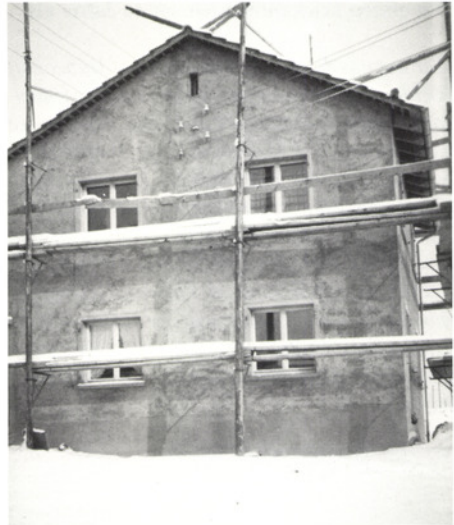
Aussen noch unfertig mussten im Winter 1944/45 über eine morastige Strasse die ersten Häuser am Frickenbuck bezogen werden.
