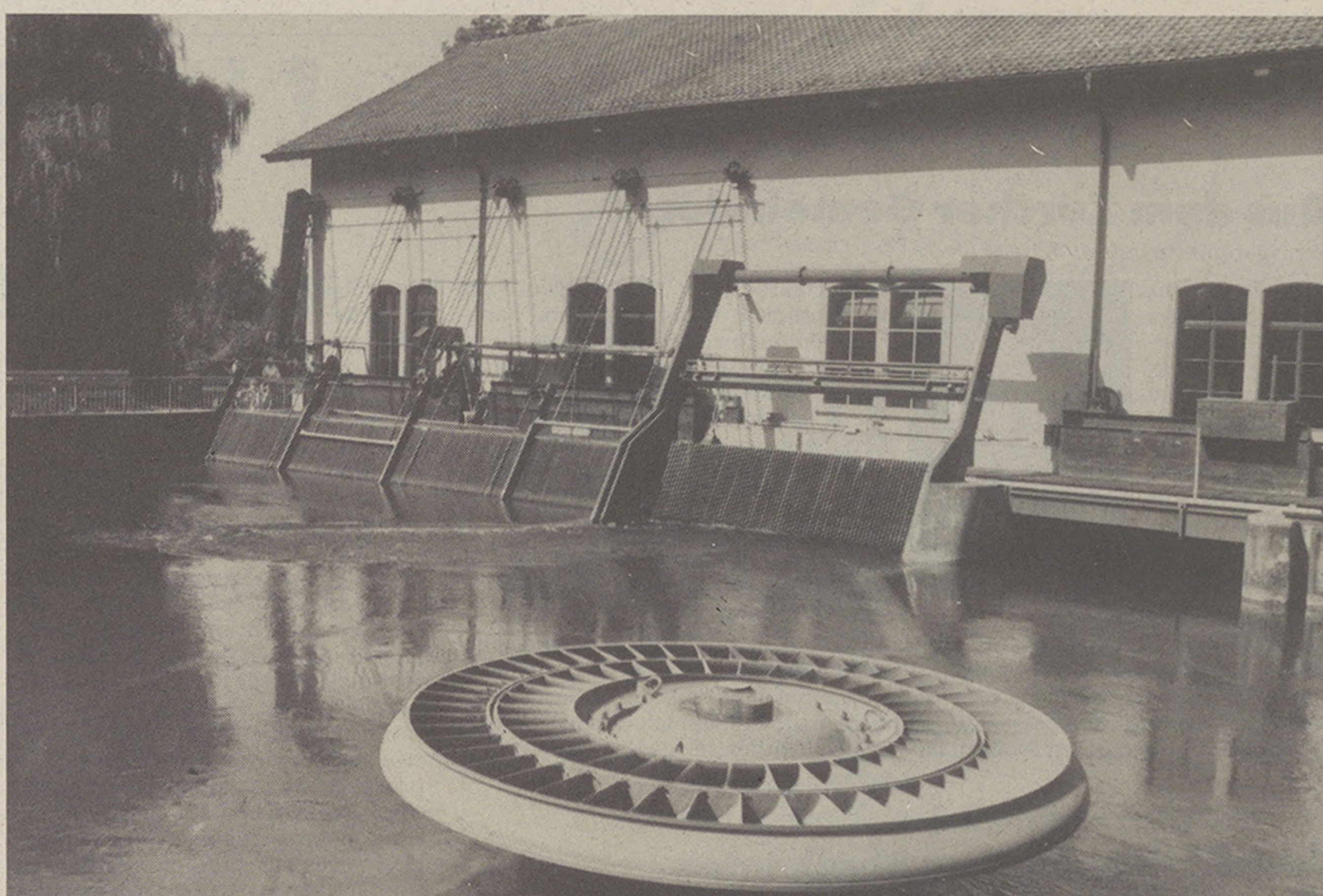
Flusskraftwerk und Museum Giessen in Hönig. Im Vordergrund das alte Turbinenrad. Seit Ende des letzten Jahrhunderts bis in die achtziger Jahre diente es der Stromproduktion... heute Teil des Museums.
