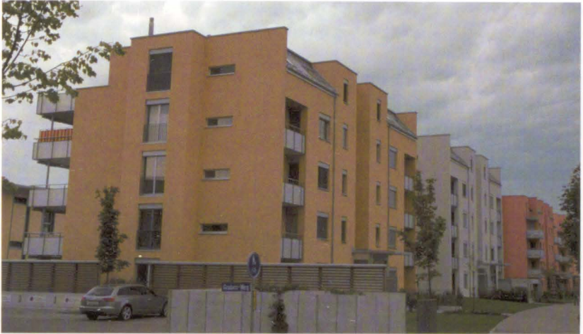
Am Zentralplatz im Gebiet In der Höh stehen zwei lange Reihen einer komfortablen und farblich differenzierten, aber nicht herausragenden Bauweise.
