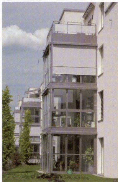
Wintergärten statt Balkone erweitern die Wohnung auch, wenns nass und kühl ist. Die Steiner-Siedlung beim Schulhaus In der Höh bietet den Fünfer und das Weggli.
