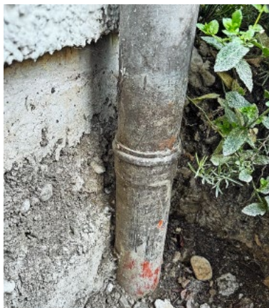
Neu fliesst das Wasser vom Dachkännel direkt in den Tank. Bild: Alfio Zweifel
