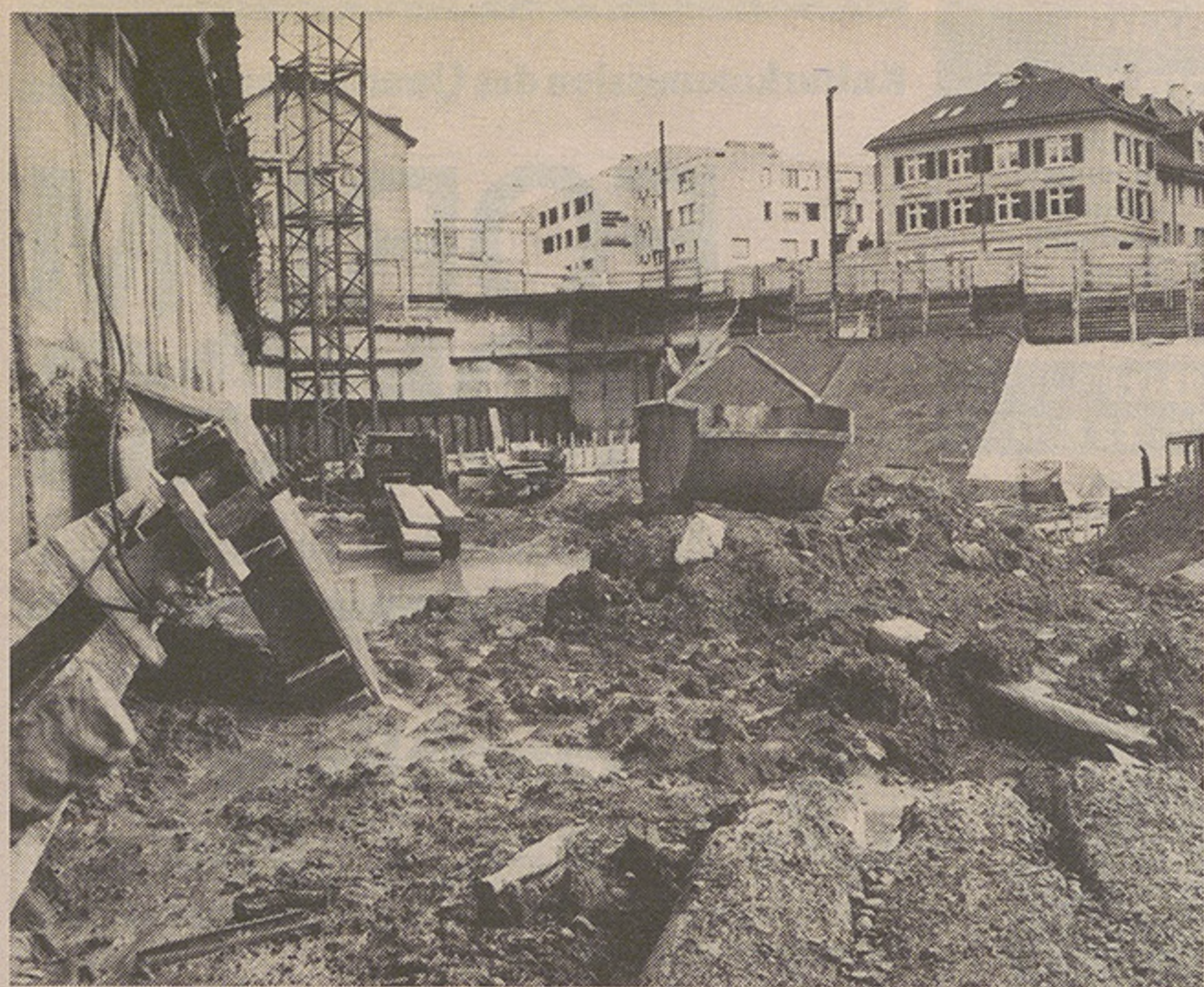
Höngg im Untergrund. Eine tiefe, sehr tiefe Baugrube von immensem Ausmass, wie es Höngg wohl noch nie sah. Vorbereitung auf den Höngger Markt. Die Bauten im Zentrum Höngg werden in den Formen und Dimensionen den alten, abgerissenen Häusern angepasst. Wir erhalten in Höngg ein Dorfzentrum, kein Supermarkt; wir freuen uns.
