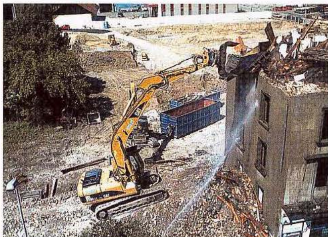
Hier geht's dem Haus Bahnhofstrasse 11, Poststelle von 1900–12, an den Kragen bzw. ans Dach.
