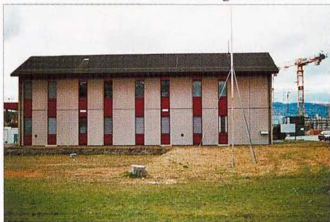
Die neue Telefonzentrale an der Güterstrasse 9
