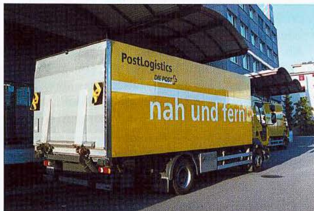
An der Rückseite des Gebäudes werden die Rollgestelle und Sammelbehälter aus den Lastwagen über die eingebaute hydraulische Ladeplattform in die Sortierhalle gerollt.
