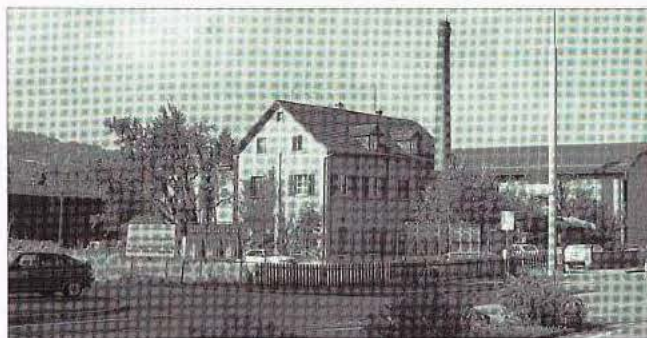
Die Asphalt-Emulsion AG; rechts die neue Telefonzentrale
