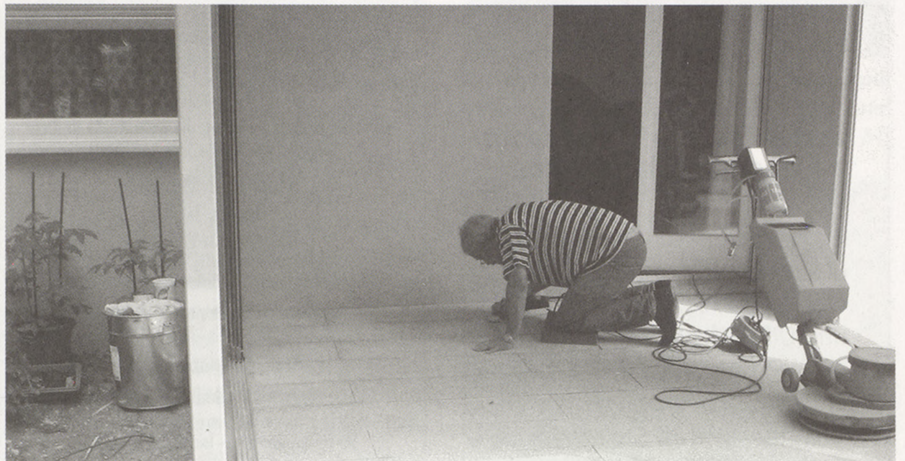
Nicht etwa Granitplatten liegen hier, sondern Platten aus 500 recycelten Skischuhen.
