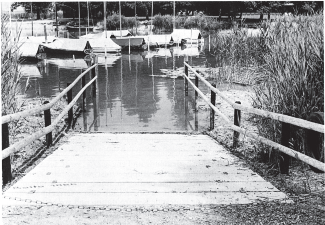
Slipanlage beim Strandbad Auslikon
