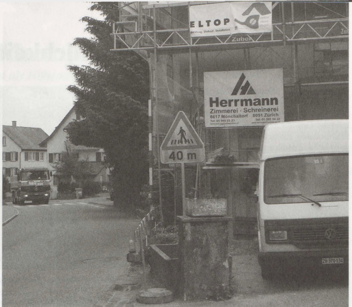
Das umgebaute Wohnhaus Zürichstrasse 213, vor dem das Trottoir gebaut wird, das vom abzubrechenden Brunnentrog bis an das Ende den Gartens im Hintergrund führt.
