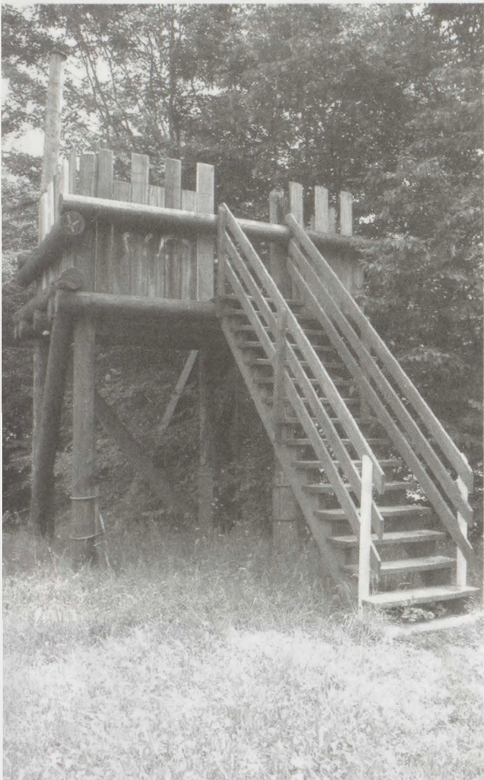
Der erst vor kurzem wieder in Stand gestellte Kletterturm im Hasenbüel. (Fotos: fri)
