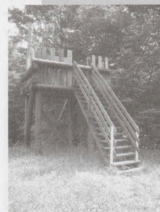
Spielplatzbeschädigungen werden immer häufiger.
