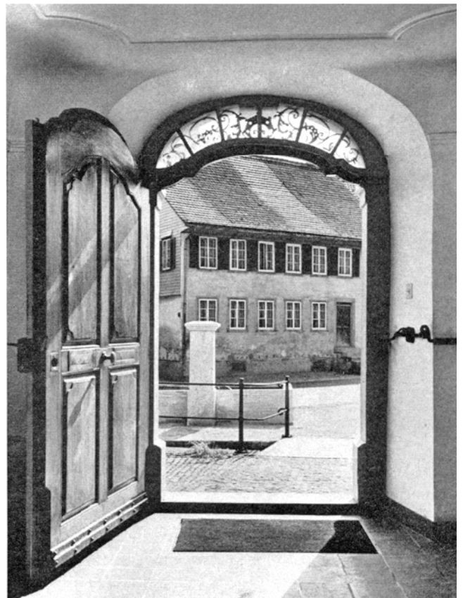
Wila. Reformiertes Pfarrhaus. Hauptportal. Nach der Renovation 1965.
