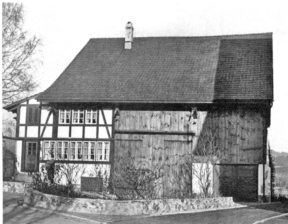
Seegräben. Ehemaliges Bauernhaus Vers.-Nr. 6, nach Renovation und Umbau.
