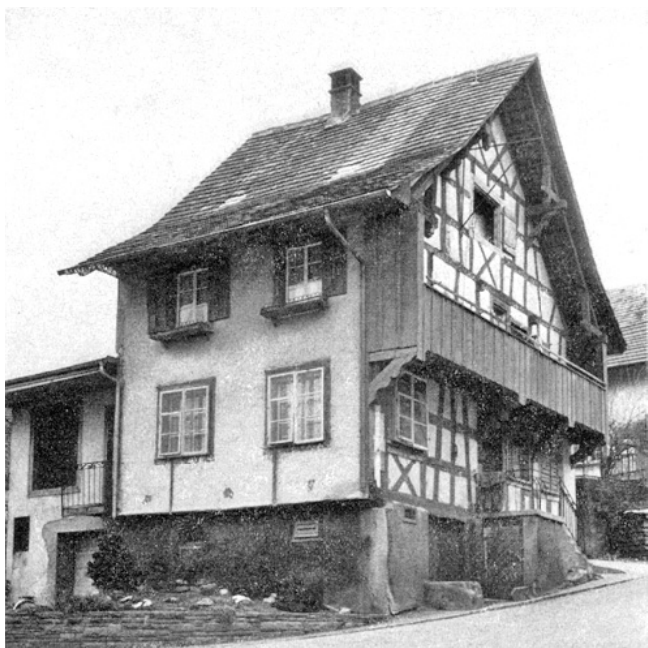
Hüntwangen. Haus Vers.-Nr. 63. Vor der Renovation.
