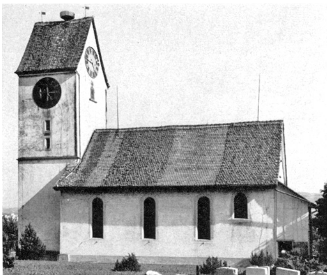
Buchs. Reformierte Kirche. Nordfassade vor der Restaurierung.
