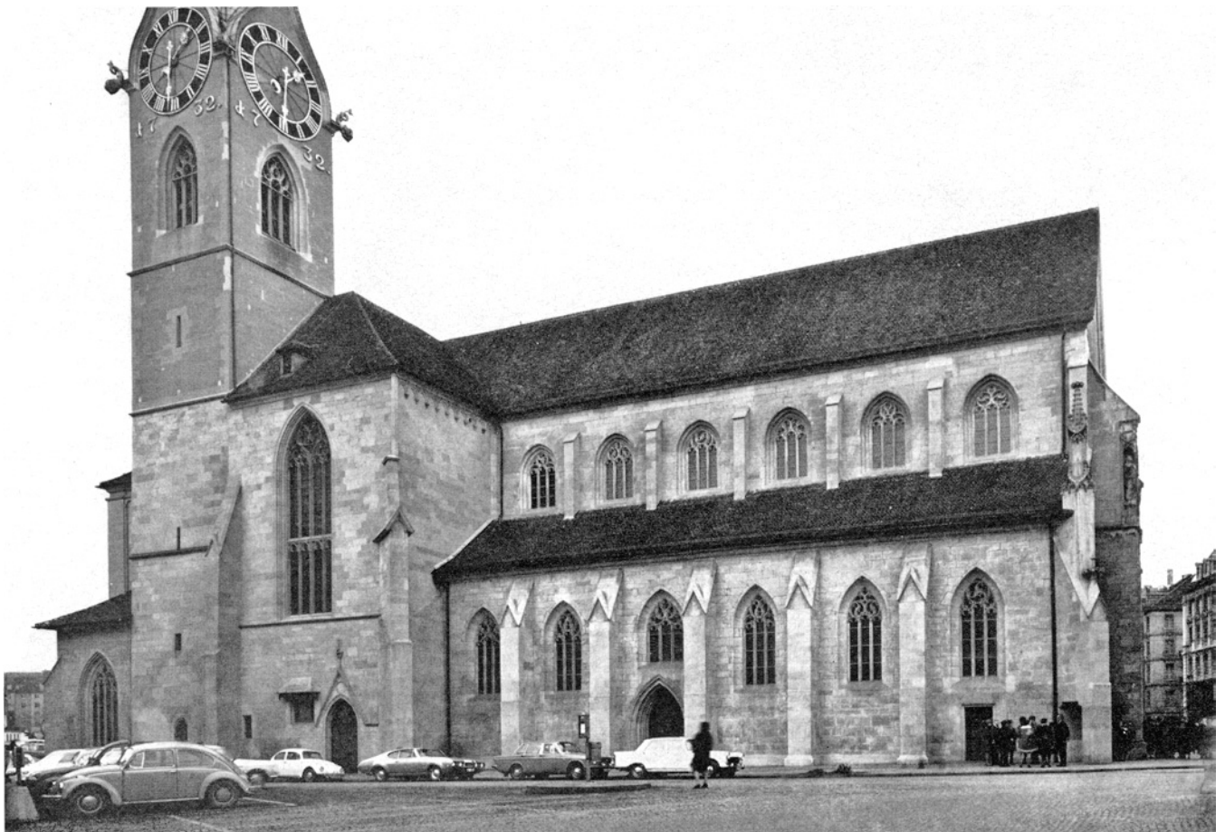
Fraumünster. Die restaurierte Nordfassade des Langhauses.
