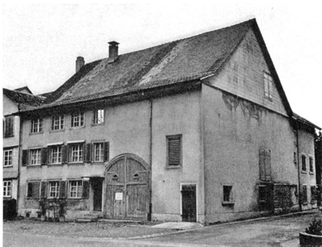
Elgg, Obergasse. Ehemaliges Bauernhaus Vers.-Nr. 273, abgebrochen 1966.
