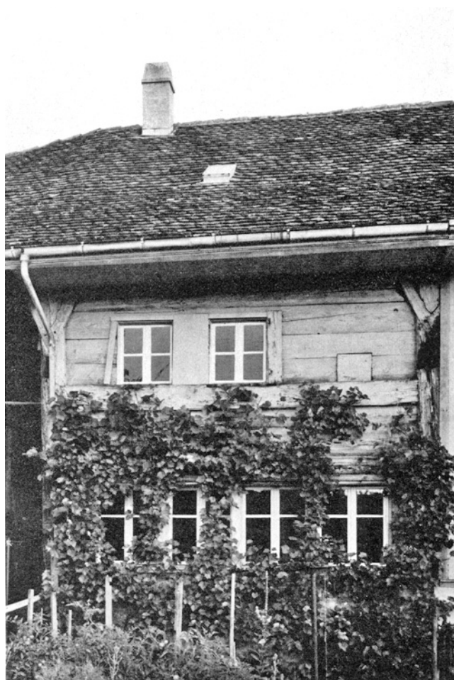
Rüschlikon. Vordere Gasse 7. Blockständerbau, abgebrochen 1968.
