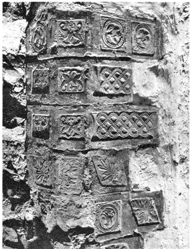
Erlenbach. Schulhausstrasse 47. Ehemaliges Bauernhaus. Romanisches Portal. Detail mit einigen St. Urban-Backsteinen.
