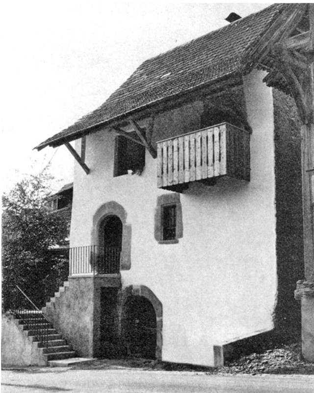
Schöfflisdorf. Ehemaliger Speicher von 1604, nach der Renovation.
