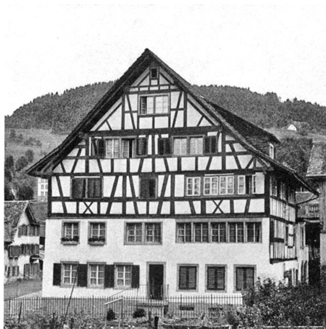
Wald. Unter-Punt. Haus Vers.-Nr. 1553, nach der Renovation.
