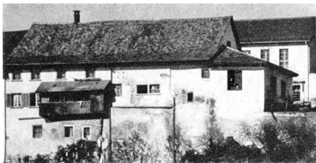
Regensburg. Unterburg. Ehemalige Kleinbauernhäuser Vers.-Nr. 10 und 11, abgebrochen 1967.
