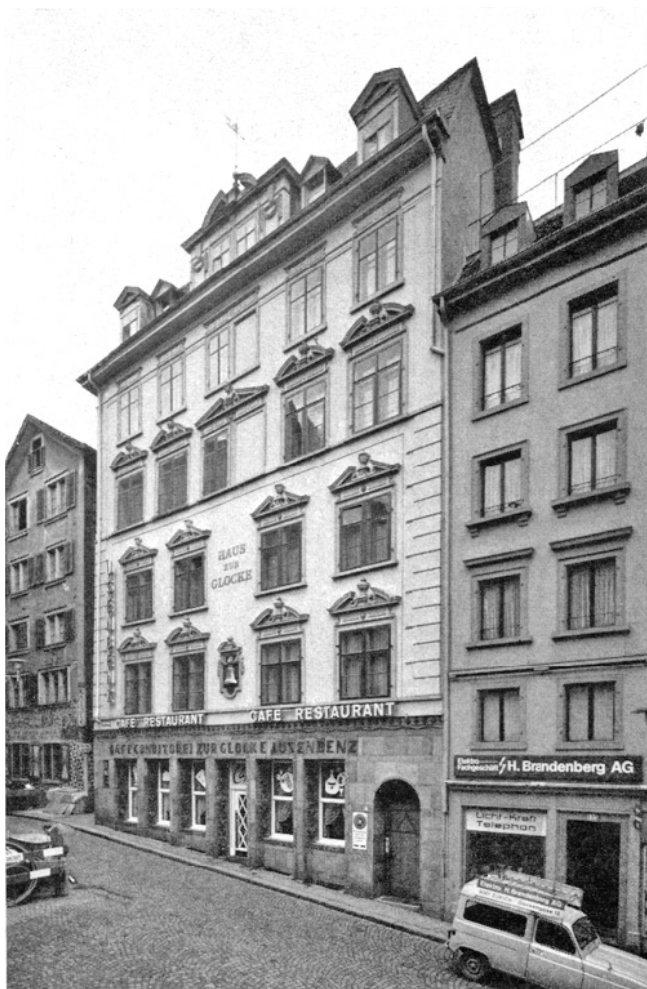
Glockengasse 9. Fassade nach der Renovation.
