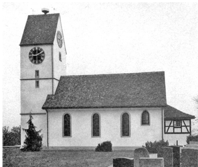
Buchs. Reformierte Kirche. Nordfassade nach der Restaurierung.
