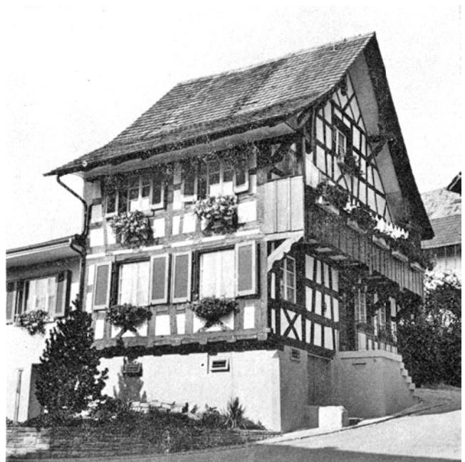
Hüntwangen. Haus Vers.-Nr. 63. Nach der Renovation.
