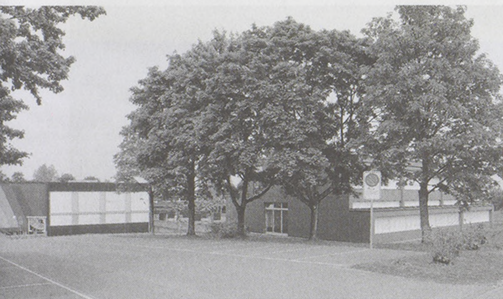
Ein Teil der grossen Schulhausanlage Looren auf der Forch. (Fotos: Sandro Pianzola)
