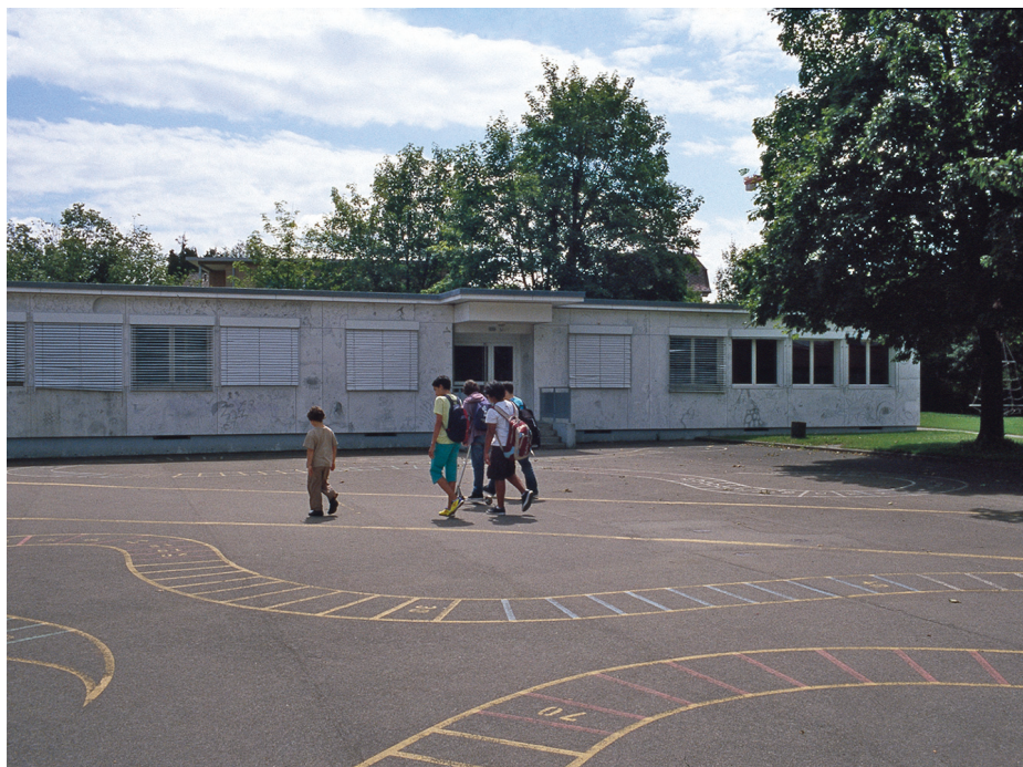
Dieser 1996 erstellte Pavillon ersetzt zwei von der Primarschule benötigte Schulzimmer.
