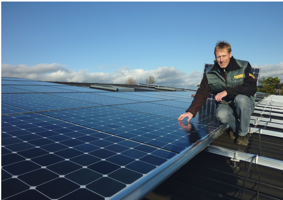
Mit grosser Freude erläutert Beat Rohner Details der hocheffizienten Solaranlage auf dem Dach der Lager- und Werkhalle der Rohner Gartenbau AG.
