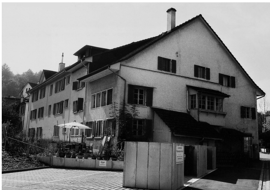
Das Gebäude Stettbachstrasse 47/49/51 im September 2012.
