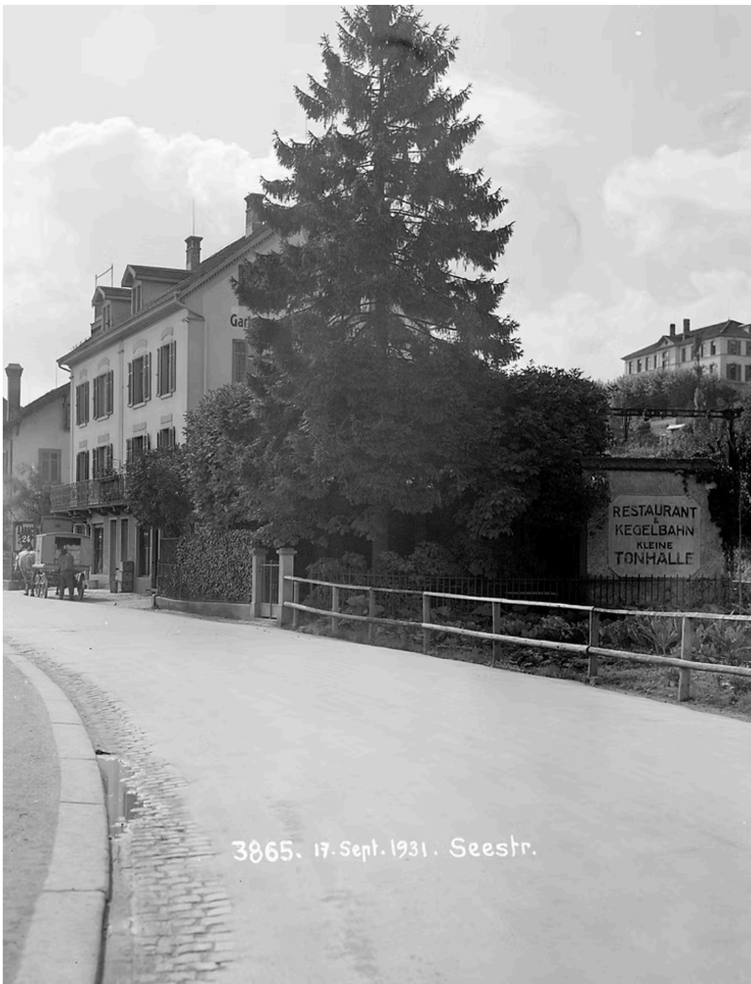
Restaurant Kleine Tonhalle mit Kegelbahn. 1931. BAZ.
