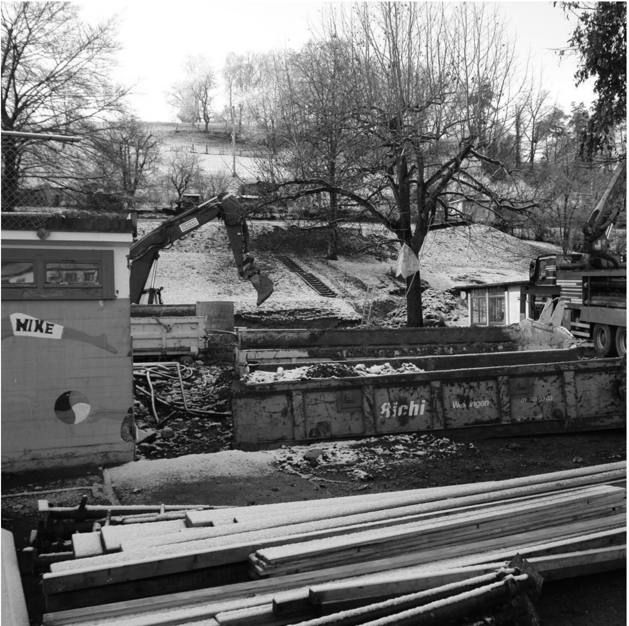
Anfangs September begann die Sanierung des Schwimmbades im Moos.
