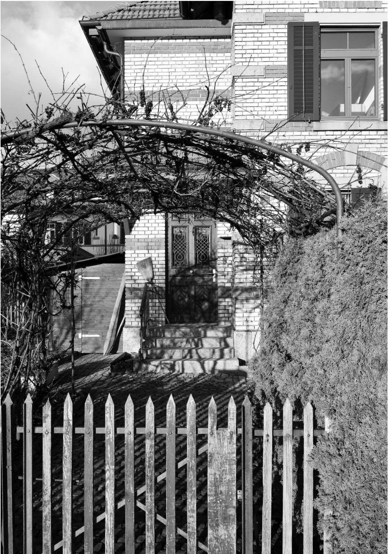
Wohnidylle: Eines der Arbeiterhäuser von 1900 / 1901 gegenüber dem Gaswerkareal.
