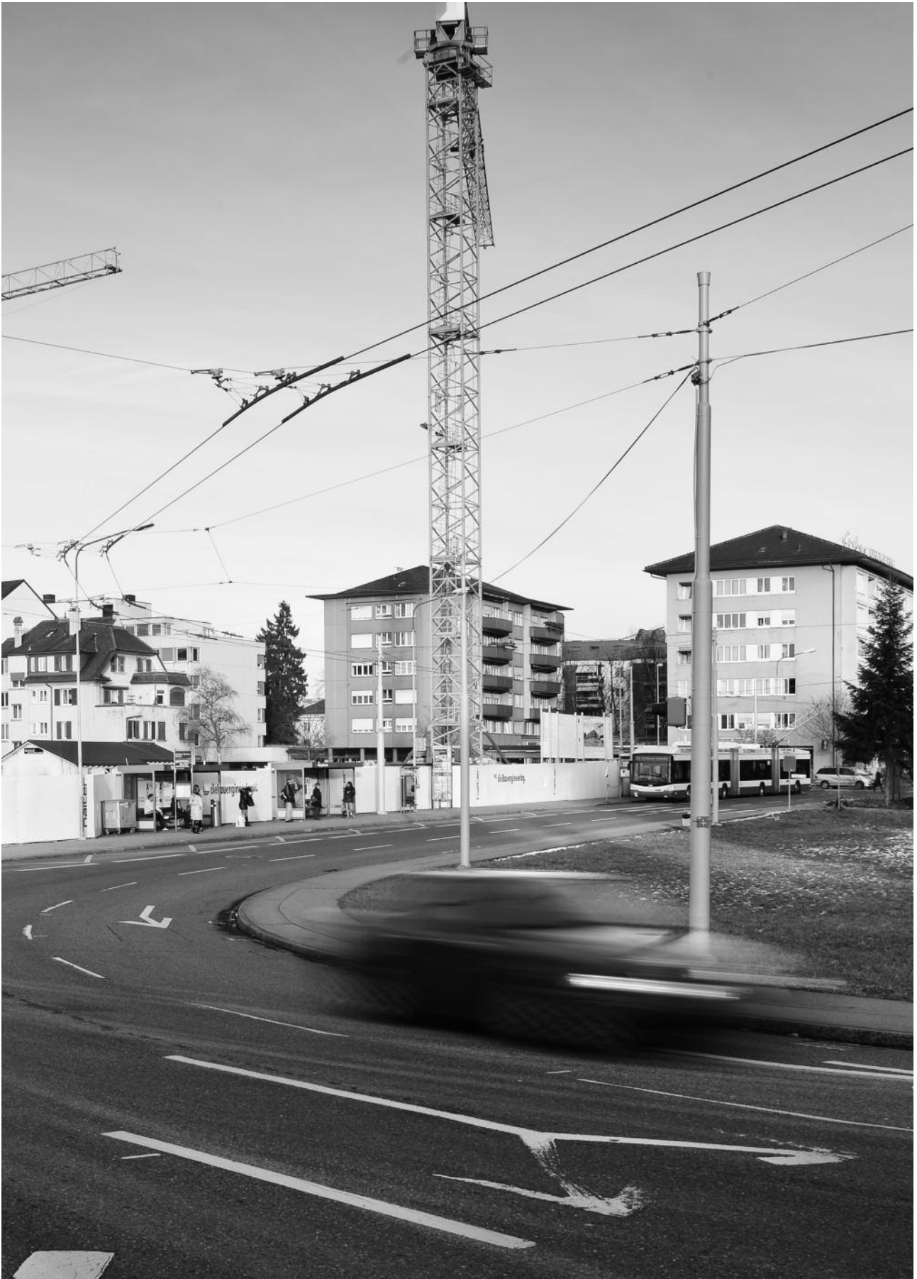
Die Baustelle "Parkside" im Zentrum zu Beginn des Jahres 2010.
