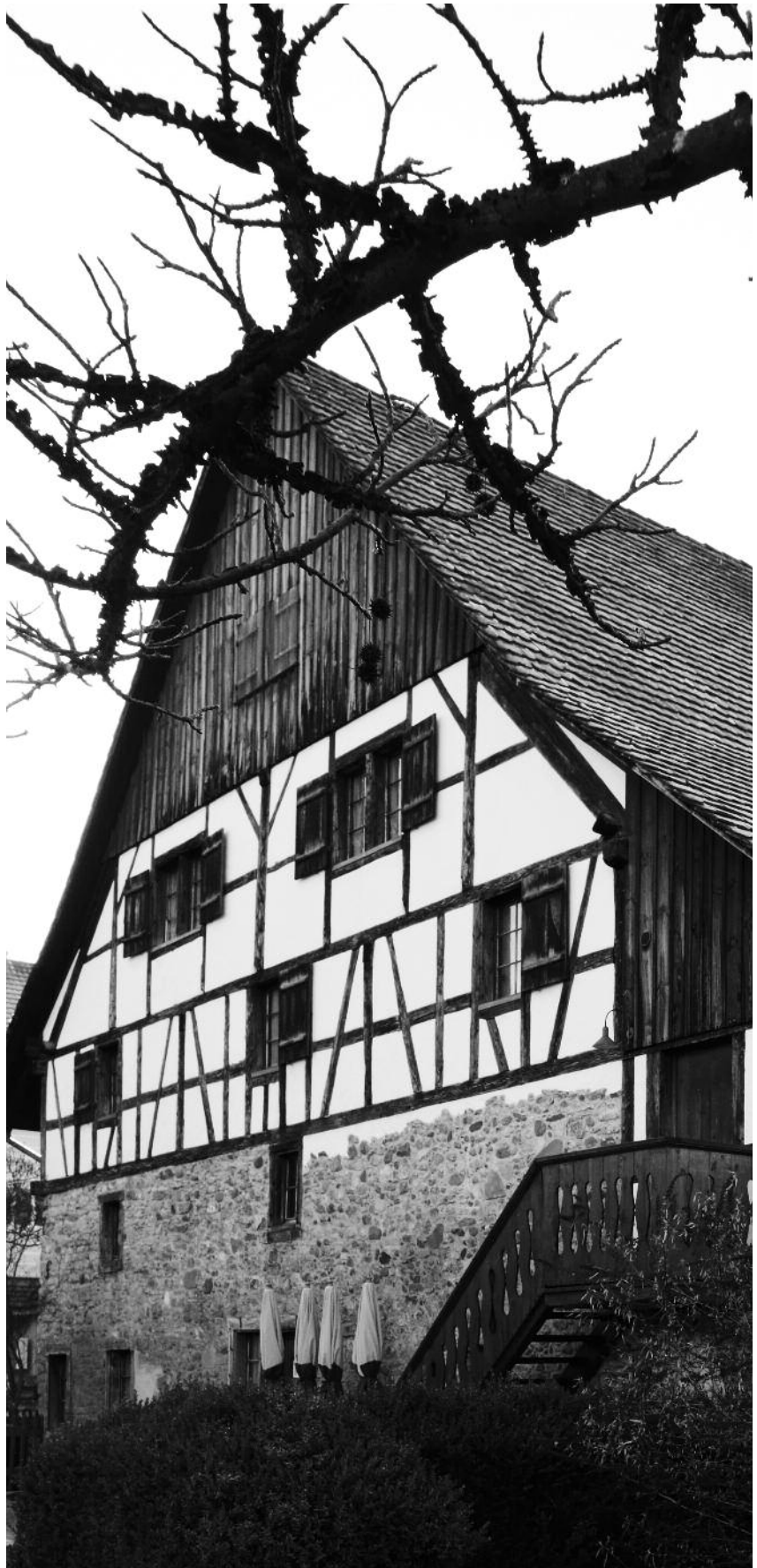
Das kommunale Bauteninventar ist auf der Homepage der Stadt Schlieren für alle öffentlich zugänglich.
