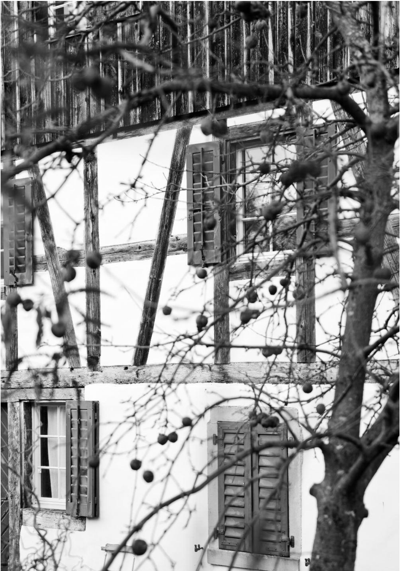
In Schlieren gibt es noch einige Fachwerkhäuser, die Zeugen einer bäuerlichen Vergangenheit sind.
