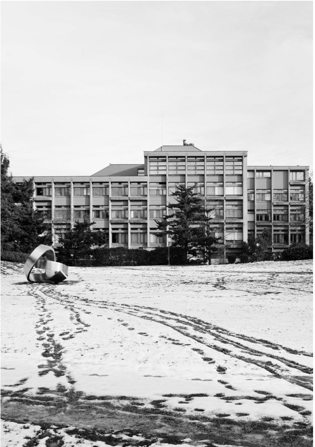
Das Stadthaus wird saniert und ausgebaut: Im 2010 begannen die Arbeiten dazu.
