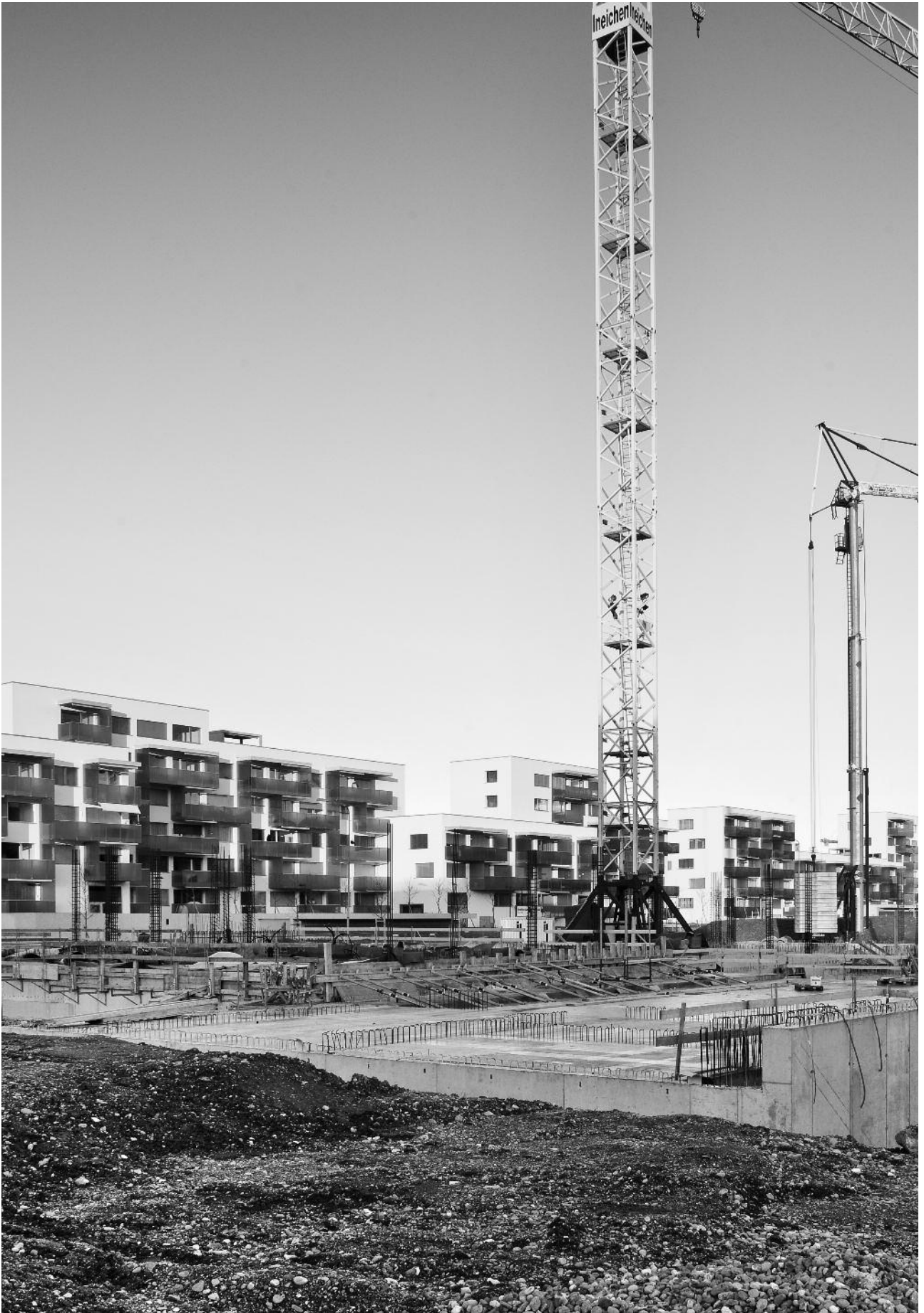
Zwischen Güterstrasse und Badenerstrasse entsteht die Überbauung "Gartenstadt".
