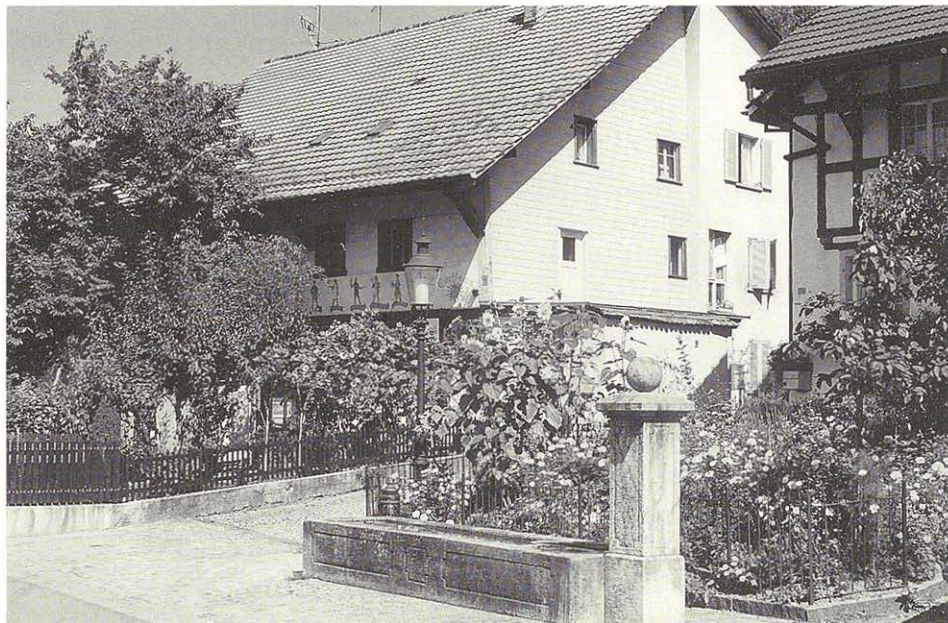
Das mit 1605 datierte Bauernhaus an der Unterdorfstrasse 20 in Wangen dürfte zu den ältesten Bauten des Dorfes gehören. Obschon es schon mehrfach umgebaut wurde, enthält es noch viele originale Bauteile des ehemaligen Bohlenständlerhauses. Im Vordergrund der älteste noch erhaltene Brunnen Wangens aus dem Jahre 1794.
