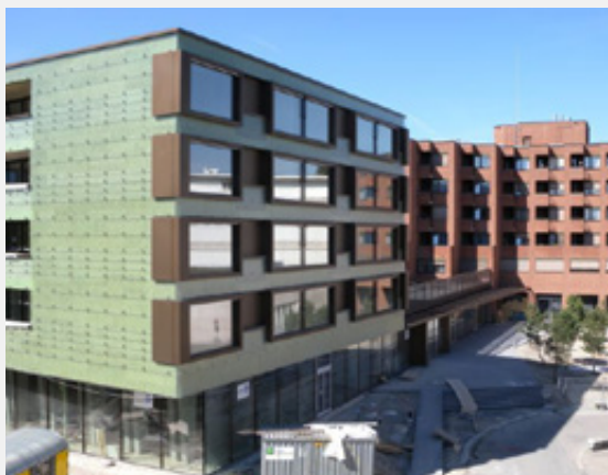
Alterszentrum Bruggwiesen: Einweihung von Neubau und saniertem Altbau
