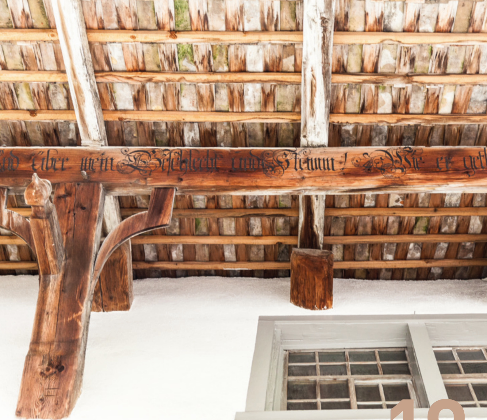
Dachbalkenspruch von 1804 und antikes Sprossenfenster mit Schieber am Hotzehaus
