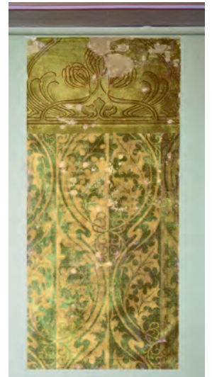
2. Obergeschoss, Treppenhaus. Referenzfeld mit bauzeitlicher Tapete im oberen Wandbereich. Zustand nach der Restaurierung, August 2011. KDP Fotoarchiv.
