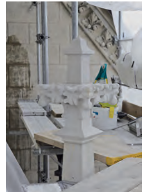
Oben: Ausschnitt der ersetzten mittleren Kreuzblume über dem Portal des westlichen Querschiffs. Zustand während der Restaurierung, September 2010. Unten: Portal des westlichen Querschiffs. Zustand nach der Restaurierung, März 2016. KDP Fotoarchiv.
