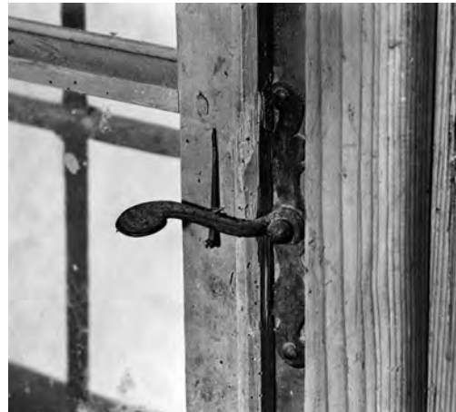
Links: Kammer 2.2 mit bauzeitlichen Bohlenwänden von 1666. Zustand während des Umbaus, April 2010. Rechts: Gang 0.1. Vorreiber am Fenster neben der hinteren Haustür. Zustand vor der Restaurierung, März 2007. KDP Fotoarchiv.
