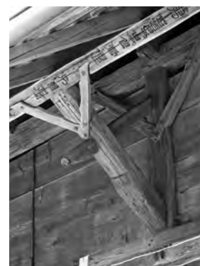
Flugpfette mit Bug und Zugband an der Südostfassade. Zustand 1980. KDP Fotoarchiv.
