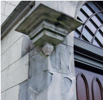
Verschiedene Schäden am Sandsteinmauerwerk der Ost- bzw. Nordfassade (Mitte). Zustand vor der Aussenrenovation, November 2008. KDP Fotoarchiv.
