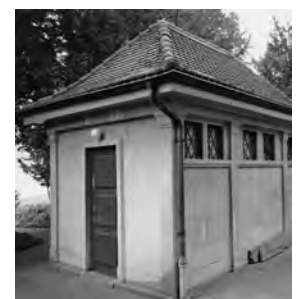
Nebengebäude mit Abort zur reformierten Kirche. Zustand April 2011. KDP Fotoarchiv.
