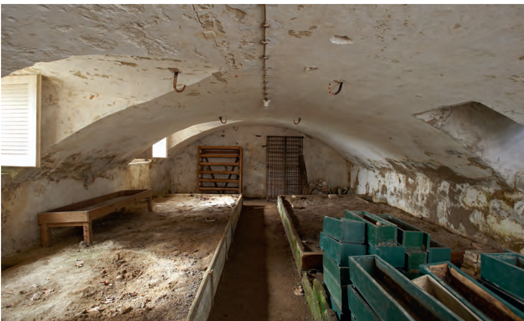
Keller mit Pflanzbeeten in der Orangerie. Zustand vor der Restaurierung, Mai 2012. KDP Fotoarchiv.
