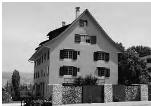
Links: Hombrechtikon, Gasthaus «Zur Krone» Vers. Nr. 541, Dörfli, Feldbachstrasse 2. Nach der Fassadenrenovation, Aufnahme 2015.
