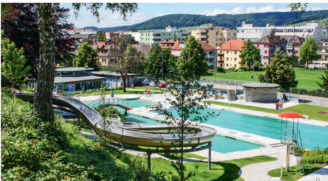
Schwimmbecken und Nichtschwimmerbereich (links) sowie Betriebs- und Garderobengebäude. Zustand nach der Sanierung und dem Umbau, September 2011. Foto Egli Gartenbau AG, Uster.
