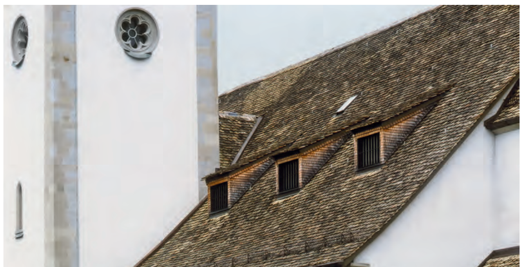
Oben: Dachreiter über dem Chor. Rechts: Ausschnitt der südlichen Dachfläche des Langhauses mit Schleppgauben. Zustand nach der Aussenrenovation, Juni 2015. KDP Fotoarchiv.
