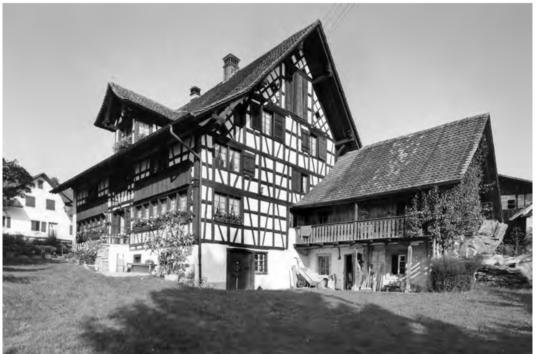
Gesamtansicht von Südosten. Zustand vor der Restaurierung, 1989. KDP Fotoarchiv.
