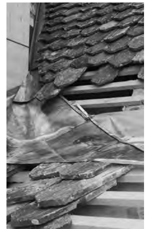
Ausschnitt der Dacheindeckung mit Biberschwanzziegeln. Zustand während des Umdeckens, Juli 2011. KDP Fotoarchiv.
