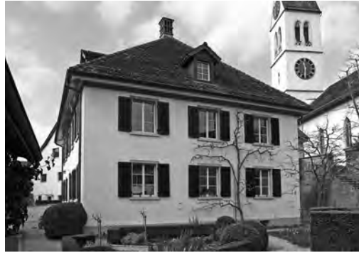
Links: Winterthur, Villa «Jungheim» Vers. Nr. 2014, Römerstrasse 36. Nach der Fassadenrenovation, Aufnahme 2015.
