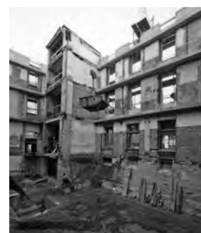
Inneres nach der Auskernung mit dem teilweise erhaltenen Treppenhaus. Zustand Juli 1982. KDP Fotoarchiv.
