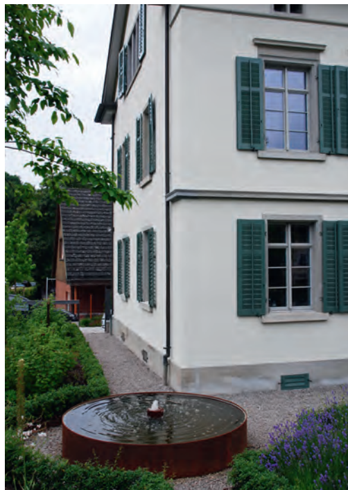
Links: Ostfassade mit Vorgarten. Zustand Juni 2011. Rechts: Neugestalteter Vorgarten mit Brunnen im Bereich der südöstlichen Gebäudeecke. Zustand Juni 2015. KDP Fotoarchiv.
