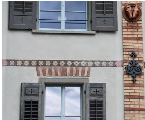
Links: Ausschnitt der Nordostfassade mit farblich differenzierter Gestaltung. Rechts: Ausschnitt der Südostfassade mit variantenreich eingesetzten Materialien und sorgfältig gestalteten Detailformen. Zustand nach der Gesamtrenovation, September 2011. KDP Fotoarchiv.
