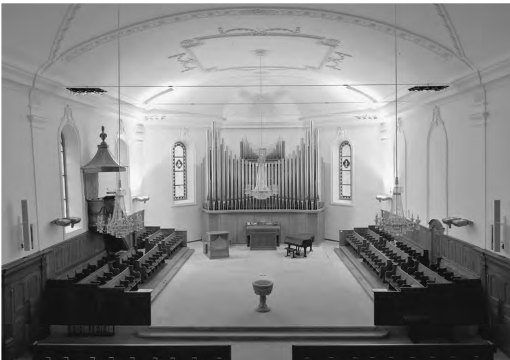
Inneres gegen den Chor mit den diskret eingesetzten Zugstangen und den neuen, den Raum um die Orgel aufhellenden Lichtstrahlern. Zustand nach der Restaurierung, Dezember 2011. KDP Fotoarchiv.
