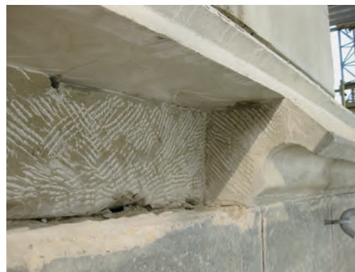
Links: Versetzen eines Gewändesteins am nördlichen Fenster des Turms. Rechts: Zurückgearbeitetes, schadhaftes Gesimsprofil an der Nordfassade. Aufnahmen während der Restaurierung, Juni bzw. Juli 2010. Aufnahmen Johann Frei, Winterthur.
