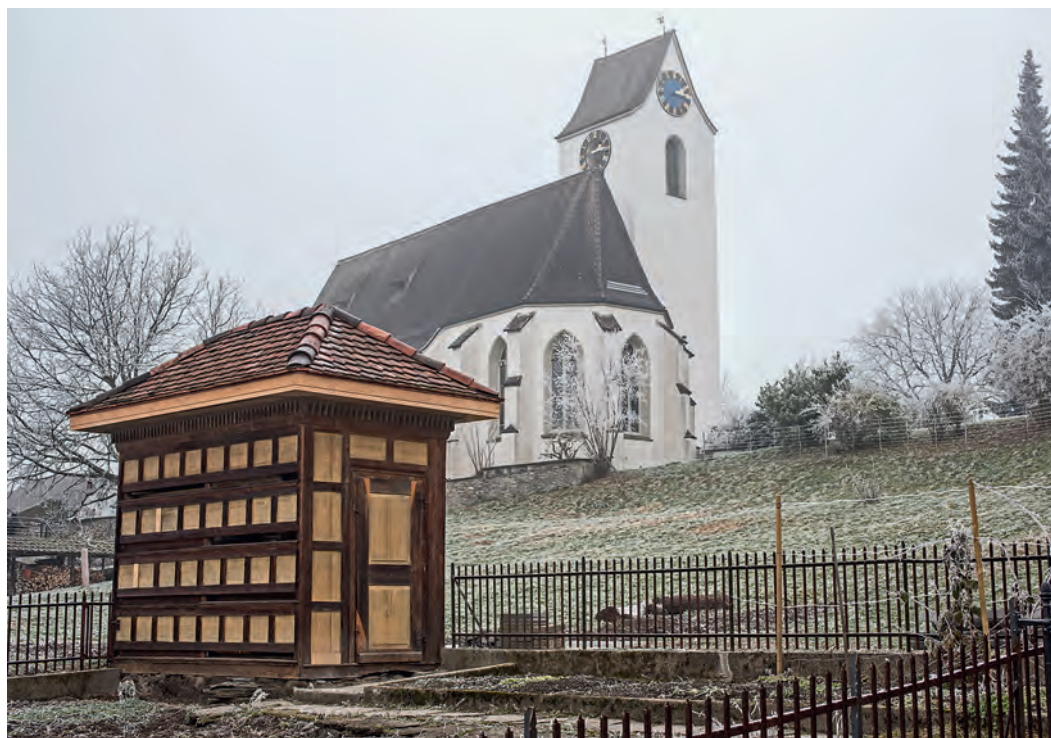
Bienenhaus mit reformierter Kirche von Südosten. Zustand nach der Instandstellung, Dezember 2013. KDP Fotoarchiv.
