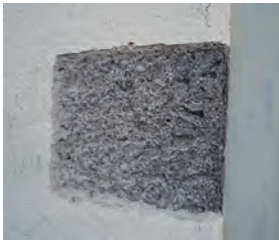
Freigelegte bauzeitliche anthrazitgraue Farbe an der Fassade. Zustand während der restauratorischen Voruntersuchung. Dok. 15, S. 12.
