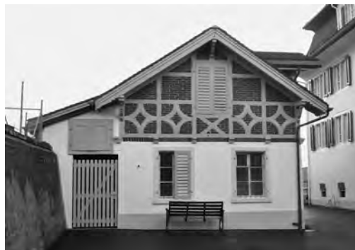
Links: Obfelden, Weberei- gebäude Vers. Nr. 258 zur Seidenweberei Stehli, Stehlistrasse. Abbruch 2012, Aufnahme 2009.
