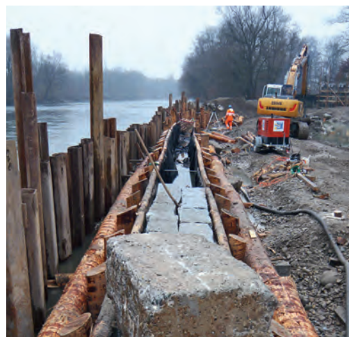
Sanierung bzw. Neuerrichtung des Streichwehrs mit einer zum Holzkasten parallel verlaufenden Spundwand. Zustand vor der Hinterfüllung mit Beton bzw. während der Einbringung der Steinfüllung, Februar 2011. KDP Fotoarchiv.
