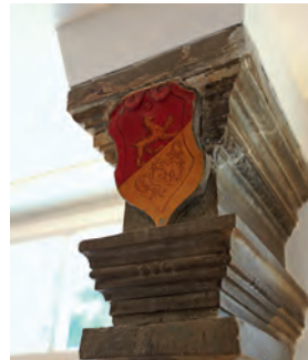
Links: Raum 1.01. Balkendecke mit aufgemalter Marmorimitation. Zustand während der Freilegung, November 2011. Rechts: Raum 0.06. Wappen der Familie Escher vom Luchs an der östlichen Fenstersäule. Zustand Juni 2012. KDP Fotoarchiv.
