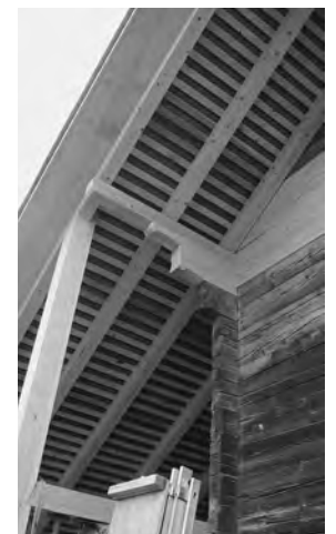
Ausschnitt der östlichen Blockfassade mit neuem Rafendach. Zustand während der Instandstellung, September 2011. KDP Fotoarchiv.
