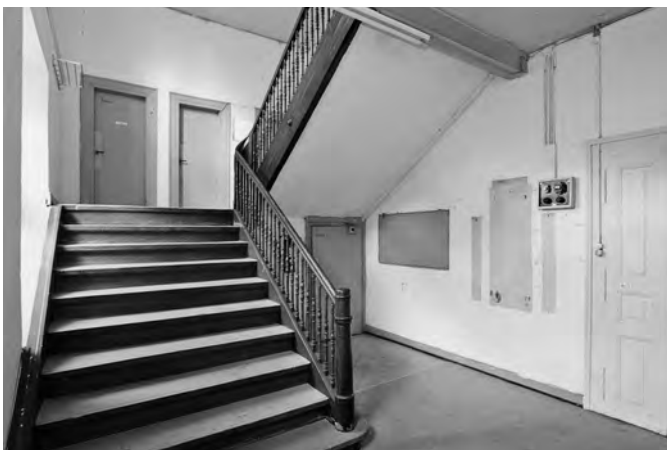
Unten links: Treppenhaus (Erdgeschoss). Zustand vor der Restaurierung, Juni 2010. Unten rechts: Fabrikaal im Obergeschoss. Zustand vor dem Umbau, Juni 2010. KDP Fotoarchiv.
