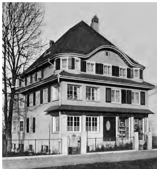
Links und rechts: Wohnhäuser mit Verwendung von Eternit bei der Fassadengestaltung. Links: 1910–1911 erbautes Mehrfamilienhaus der Architekten Fritsch & Zangerl mit Schindelschirm aus Eternit an der Breitestrasse 48 in Winterthur. Rechts: Wohnhaus der Architekten Rittmeyer & Furrer mit Giebelverkleidung aus Eternit von 1912 an der Anton Graff-Strasse 80 in Winterthur. StadtBW.
