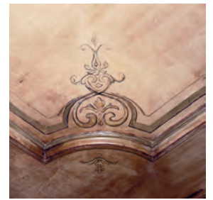
Gaststube 0.1. Stuckdecke mit Dekorationsmalerei. Zustand nach den Retuschierarbeiten, März 2009. KDP Fotoarchiv.
