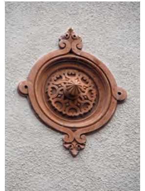
Dekoratives Medaillon aus Ton an der Südwestfassade. Zustand nach der Gesamtrenovation, September 2011. KDP Fotoarchiv.
