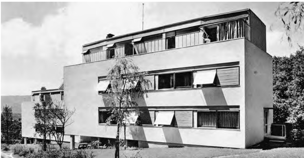
Zürich-Hottingen. Dolderhof 17, 19. Wohnhäuser, sog. Doldertalhäuser von 1935–1936. Dok. 18, S. 168.
