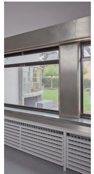
Die freigelegte Fensterverkleidung im Wohnzimmer besteht aus «Wiesilber», einer Kupfer-Zink-Nickel-Legierung. Zustand nach der Restaurierung, September 2014. KDP Fotoarchiv.
