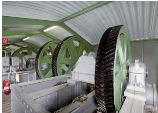
Links: Sanierter Wehrpfeiler mit geschlossenem Schützen. Rechts: Inneres der Windwerkbrücke. Zustand Juni 2013. KDP Fotoarchiv.
