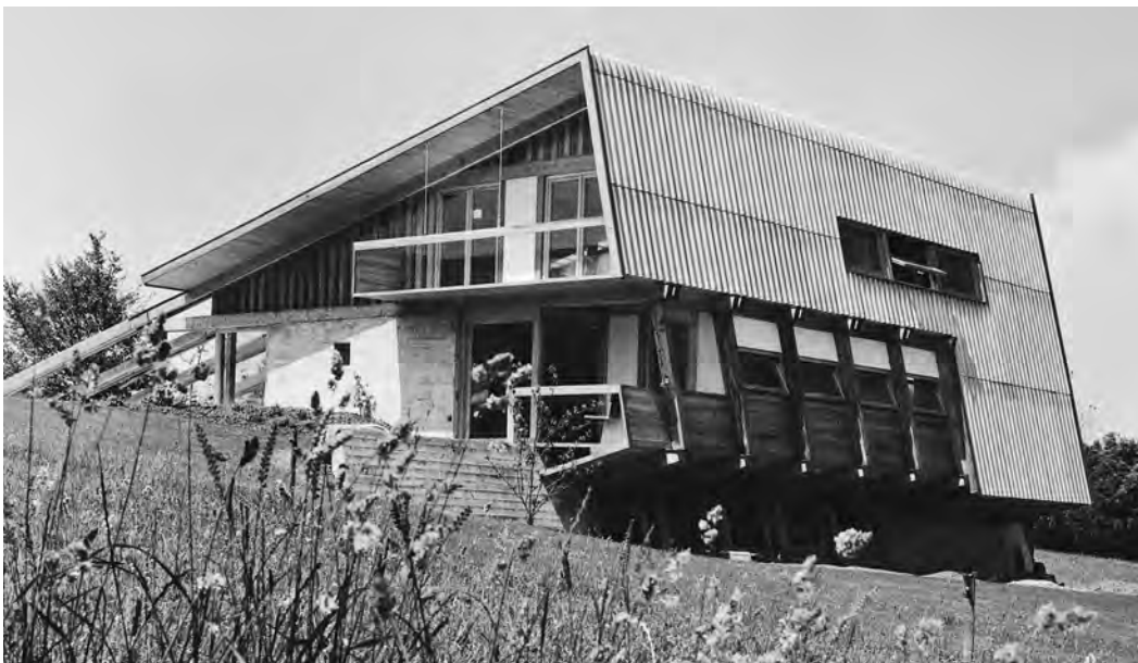
Dübendorf, Gockhausen, Nussbaumstrasse 1, Wohn- und Atelierhaus von Architekt André M. Studer, Zürich, erbaut 1959. gta Archiv / ETH Zürich, André M. Studer.
