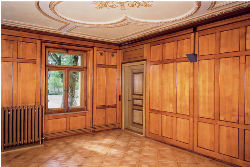
Stube im Erdgeschoss. Im obersten Bereich des Täfers sind zwei Rosetten als Abdeckung der Luftheizung erkennbar. Zustand nach der Restaurierung, September 2013. KDP Fotoarchiv.
