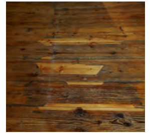
Geflickter Riemenboden einer Kammer im Obergeschoss des ehemaligen Bauernwohnhauses. Zustand Dezember 2012. KDP Fotoarchiv.
