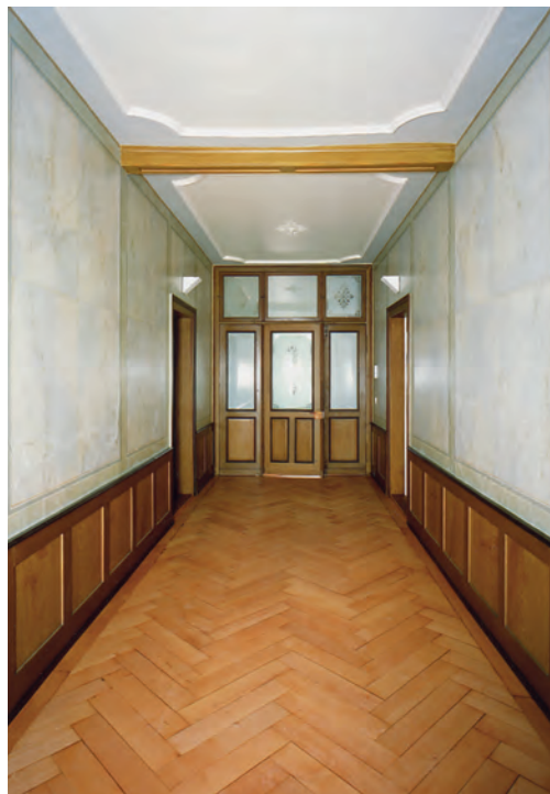
Obergeschoss. Links: Treppenhaus mit Vorplatz und Aufgang ins Dachgeschoss. Rechts: Korridor mit marmorierten Wänden über einem Knietafer. Zustand nach der Restaurierung, September 2013. KDP Fotoarchiv.
