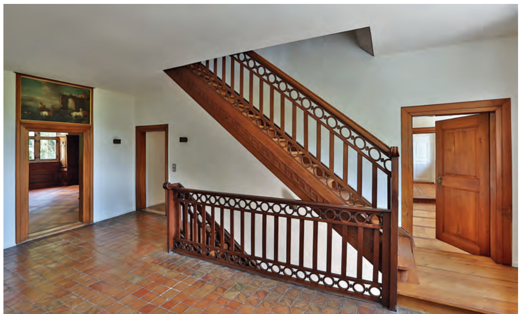
Halle 1.03. Zustand nach der Restaurierung, Juni 2012. KDP Fotoarchiv.
