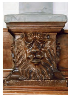
Saal 1.09. Hölzernes Postament für die Fenstersäule. Zustand vor der Restaurierung, Juni 2011. KDP Fotoarchiv.
