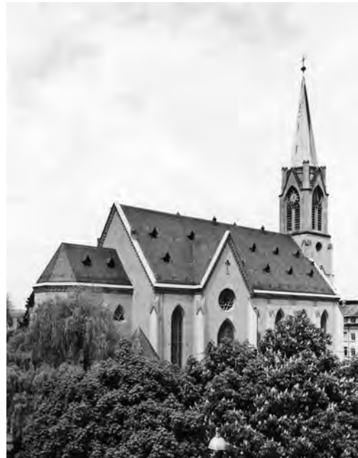
Links: Historische Aufnahme von Nordosten, um 1880. StadtBW. Rechts: Die Ostfassade nach der purifizierenden Renovation von 1957. Aufnahme Mai 1976. KDP Fotoarchiv.
