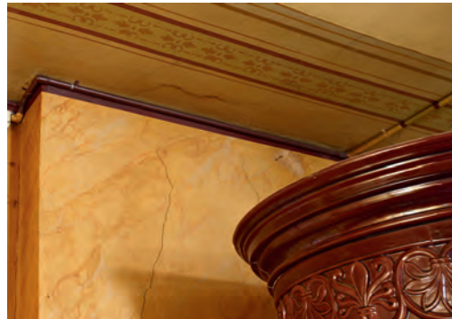
Stube im 1. Obergeschoss. Ausschnitt der Zimmertüre mit Maserierung. Rechts: Ausschnitt der marmorierten Ofenrückwand und der Schablonenmalerei an der Decke. Zustand vor dem Abbruch, November 2010. KDP Fotoarchiv.
