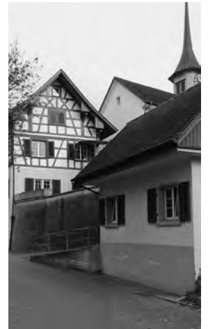
Ansicht mit Stützmauer von Südwesten. Zustand nach der Aussenrenovation, November 2015. KDP Fotoarchiv.
