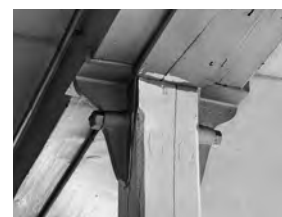
Oben: Holzstütze und Unterzug im Fabriksaal des Obergeschosses. Unten: Ansicht von Nordwesten mit Vordach und Liftüberfahrt von 1948. Zustand vor der Restaurierung, Juni 2010. KDP Fotoarchiv.
