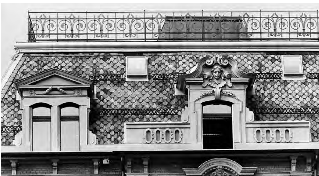
Ausschnitt des Mansarddachs mit unterschiedlich gestalteten Lukarnen. Zustand nach der Aussenrenovation 1981–1983, Juni 1985. KDP Fotoarchiv.
