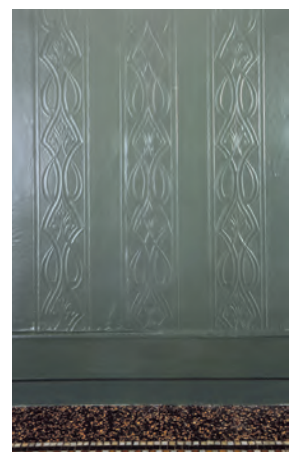
Entrée im Hochparterre. Ausschnitt der Lincrusta-Wandverkleidung. Zustand nach der Restaurierung, August 2011. KDP Fotoarchiv.
