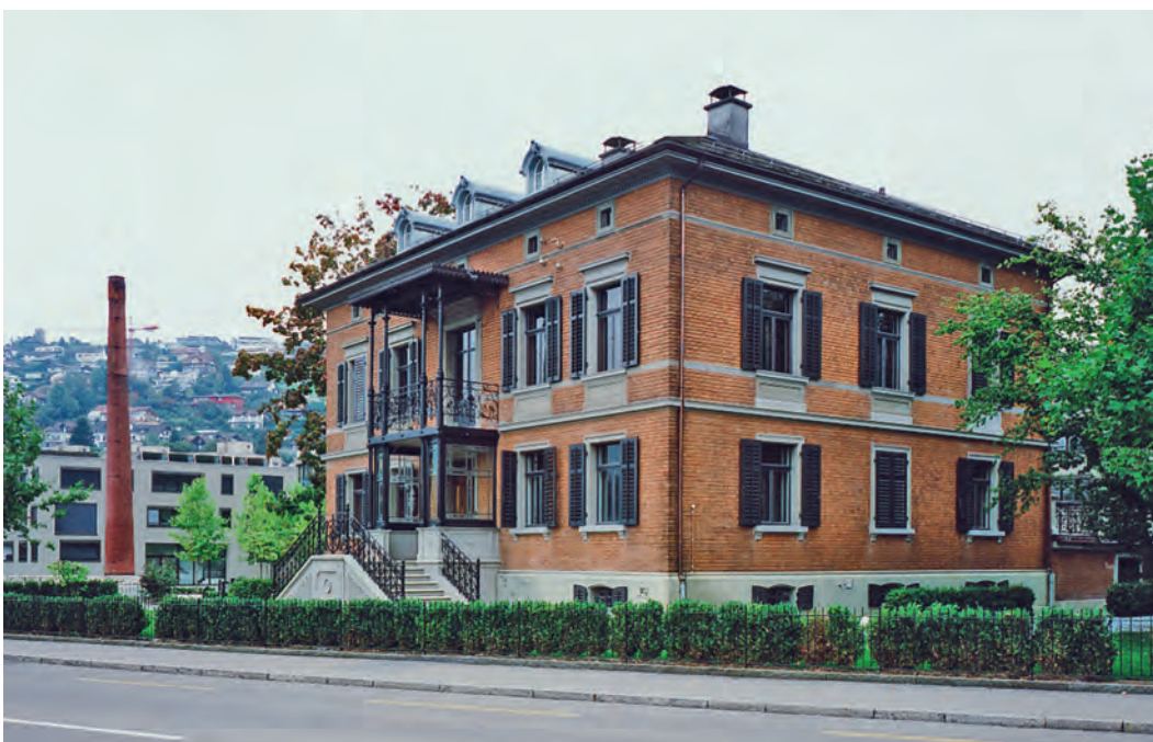
Ansicht der Fabrikantenvilla von Norden. Zustand nach der Restaurierung, September 2013. KDP Fotoarchiv.
