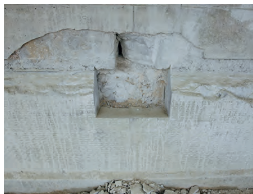
Links und rechts: Ersatz von stark verwitterten Werkstücken am Sockel der Westfassade. Aufnahmen während der Restaurierung, September 2010. KDP Fotoarchiv.
