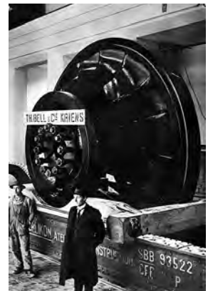
Oben: Laufradtransport für das Maschinenhaus am 13. November 1919. Original Firmenarchiv NOK, Baden, Repro KDP Fotoarchiv. Unten: Detail eines Generators mit Bezeichnung «13141 OERLIKON 1919». Zustand Juli 2013. KDP Fotoarchiv.
