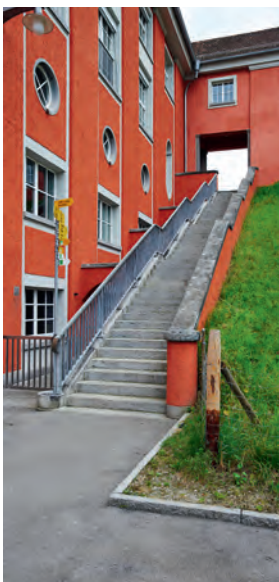
Treppenaufgang zwischen Maschinenhaus und Schaltanlagegebäude. Zustand nach der Renovation, Juli 2013. KDP Fotoarchiv.
