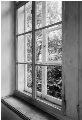
Innen- und Vorfenster im Fabrikaal des Obergeschosses. Zustand vor dem Umbau, Juni 2010. KDP Fotoarchiv.
