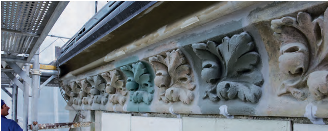
Fehlstellen an den Blättern des Traufgesimses der Westfassade wurden mit Mörtel repariert. Aufnahme während der Restaurierung, September 2010. KDP Fotoarchiv.
