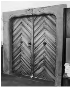
Gang 0.4b. Portal zum ehemaligen Keller 0.3. Zustand nach dem Umbau, Februar 2011. KDP Fotoarchiv.
