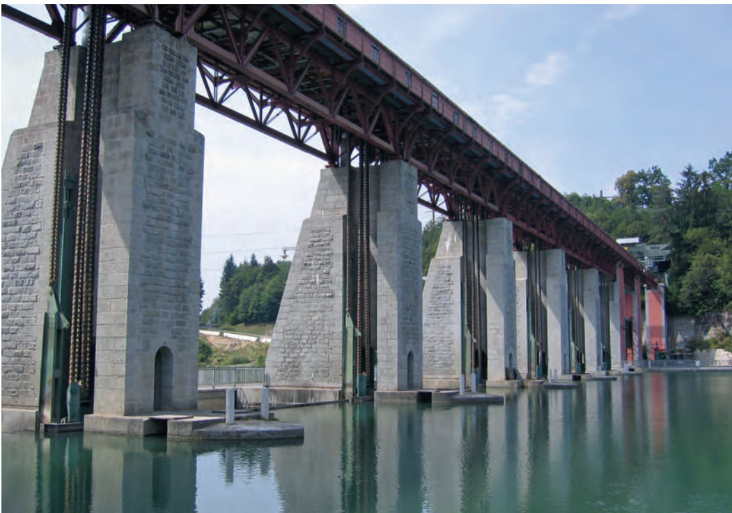
Wehr mit Wehrpfeilern und Windwerkbrücke von der Oberwasserseite her. Zustand August 2004. KDP Fotoarchiv.
