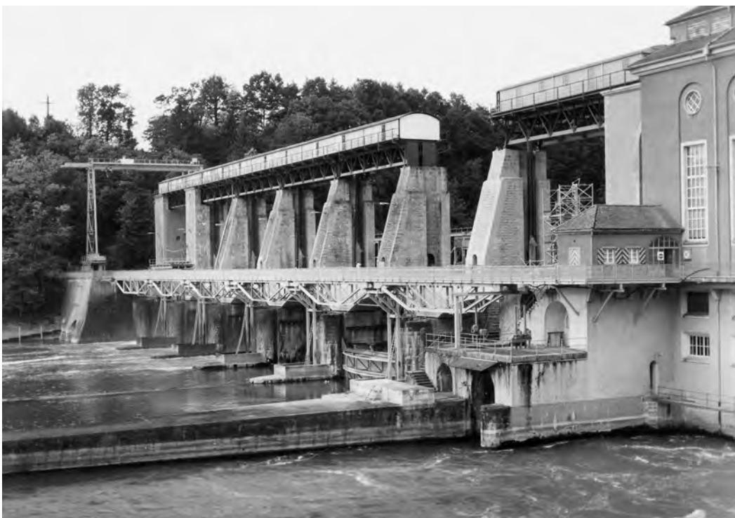
Wehr und Windwerkbrücke von der Unterwasserseite her. Zustand nach der Sanierung der ersten Wehrröfnung, Juni 1996. KDP Fotoarchiv.
