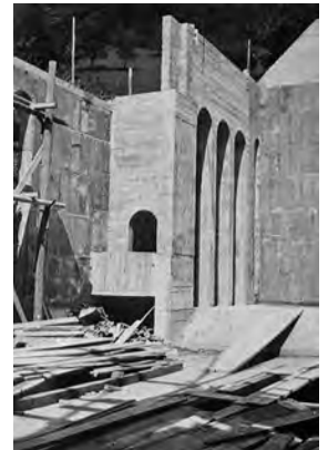
Rohbau der Kirche und des angegliederten Pfarrhauses. Aufnahme 1934. Original: Kirchgemeindearchiv der katholischen Kirche Turbenthal. Repro: KDP Fotoarchiv.
