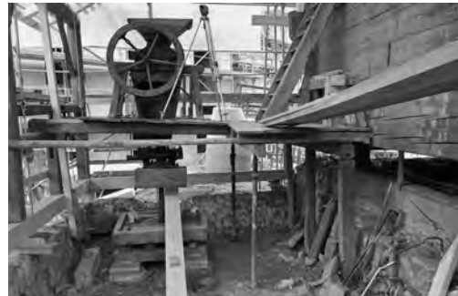
Links: Ansicht von Südwesten mit Zugangstüre am Obergeschoss. Rechts: Obstpresse im Trottenschopf. Zustand während der Instandstellung, Juni bzw. Juli 2011. KDP Fotoarchiv.
