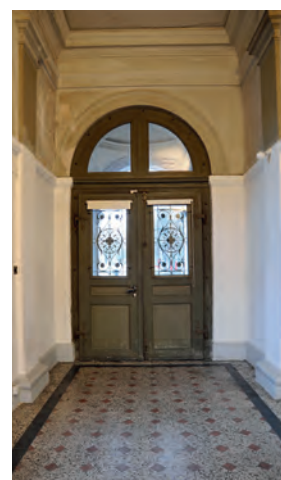
Vorbau mit Eingangstüre. Zustand vor der Restaurierung, Dezember 2010. KDP Fotoarchiv.
