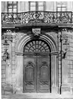
Das Hauptportal an der Südwestfassade. Aufnahme um 1880. BAZ.
