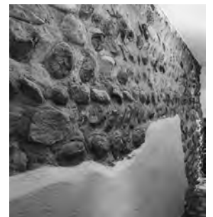
Oben: Gang 0.2. Lagenhaftes Mauerwerk der Brandmauer zwischen dem «Bären» und dem Nachbarhaus Vers. Nr. 854. Zustand Februar 2011. Unten: Alte Gaststube 1.1. Signatur des Hafners Mattias Nehracher und Jahreszahl 1764 am Kachelofen. Zustand 1961. KDP Fotoarchiv.
