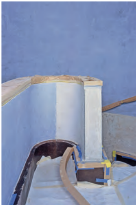
Treppenabgang vom 1. Obergeschoss ins Erdgeschoss. Unter dem weissen Anstrich erscheint die bauzeitliche blaue Bemalung. Zustand während der Restaurierung, Februar 2012. KDP Fotoarchiv.
