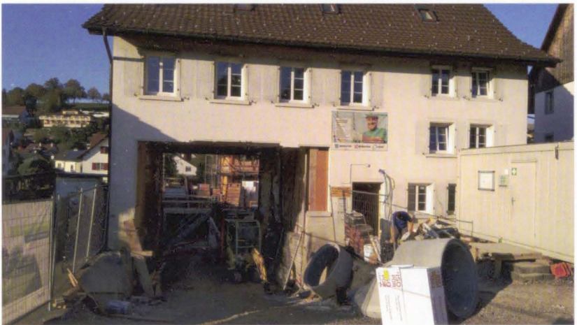
Das grosse Loch unter der Chronikstube erschliesst die Baustelle für das neue Mehrfamilienhaus hinter der Chronikstube.
