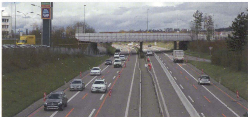
Bis Ende Oktober wird die Autobahnbrücke über die Usterstrasse saniert. Bild: Toni Spitale
