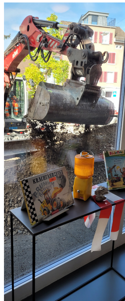
Schaufenster zur Baustelle
