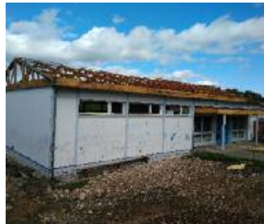
Der alte Kindergartenpavillon beim Buck macht dem Neubau Platz.
