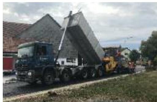
Belageinbau in der Hofwisen
