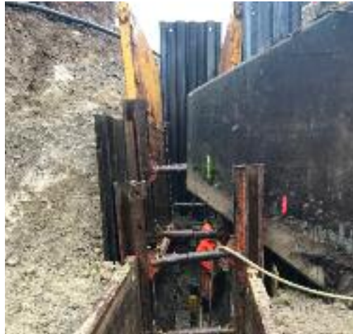
Baustelle Kanalisation: Graben Poststrasse
