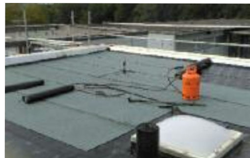
Das neue Flachdach auf dem Neubau Bachwis
