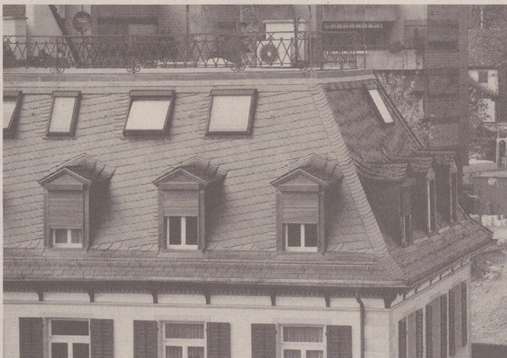
Naturschiefer aus Spanien, nach deutscher Manufaktur gedeckt – ausgeführt und zu sehen in Höngg, am Zwielfplatz.
