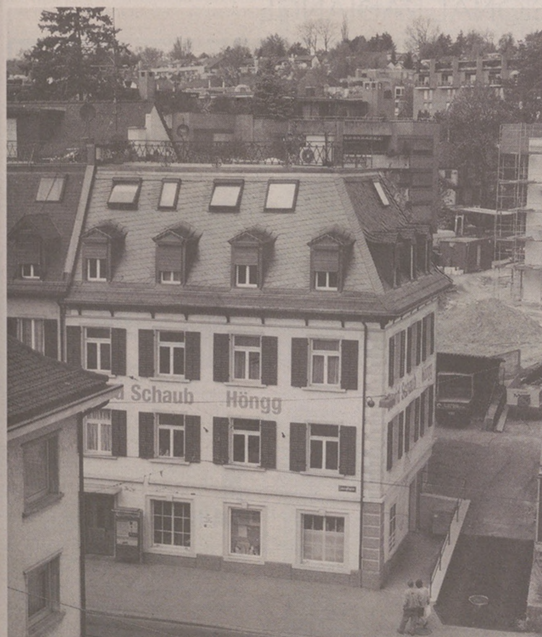
Perfekte Handwerksarbeit vom diplomierten Fachmann: ein schönes Dach über dem Kopf und vom Hausbesitzer Malermeister Schaub farblich dezent gestrichen.
