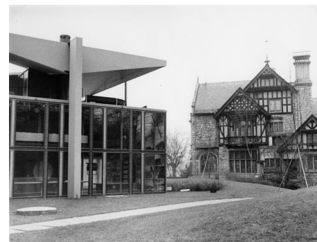
Neu und alt: Pavillon Le Corbusier und Villa Egli (Bild: BAZ_127573)
