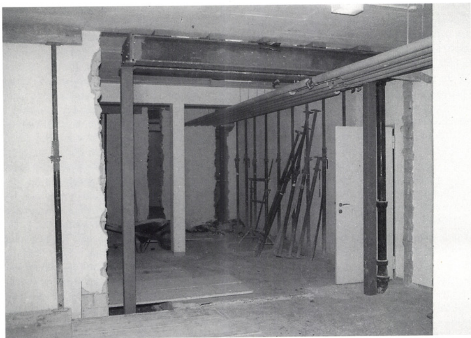
Die fertige Abfangung nach dem Aufpressen und nach dem Abbruch der alten Tragwand.
