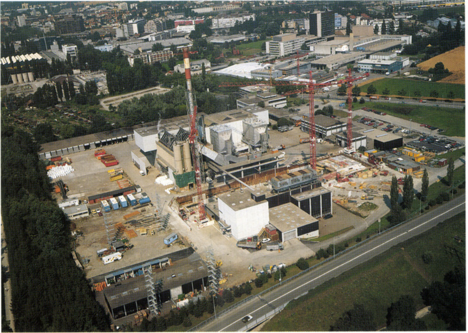
Blick auf die bestehende Kehrlichtverbrennungsanlage (KVA) Hagenholz und auf die Erweiterungsbauten für die Rauchgasreinigung, die 1993 ihren Betrieb aufnehmen wird.
