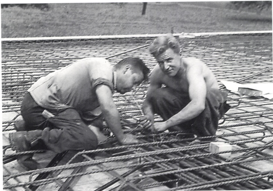
Die Installationsabteilung verlegt im Juni 1955 Elektrorohre im Neubau Oertli an der Zürichstrasse. Bruno Baumann (rechts) und Hans Schärer.
