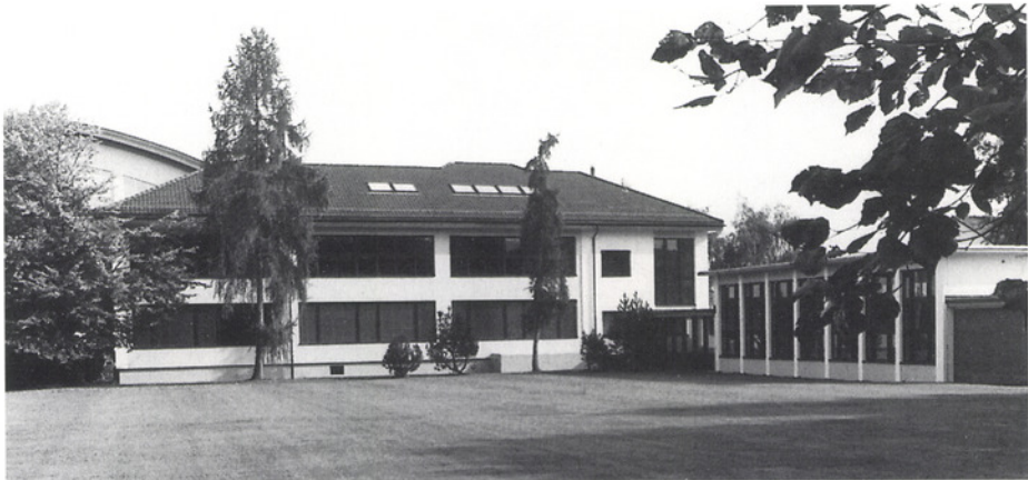
Die 1962 errichtete Quartierschulanlage Flugfeld wurde umfassend renoviert: Primär wurde das undichte Flachdach durch ein neues Steildach ersetzt.
