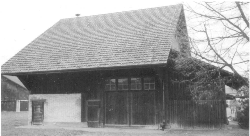
Auch in dieser zur Liegenschaft gehörenden Scheune schwamm das eingelagerte Gut munter im Wasser herum. (Bilder: Hansjürg Fels)
