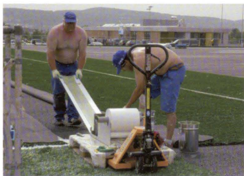
Zuerst Asphalt, dann künstliches Grün draüber: der neue Kunstrasen im Gries wird verlegt. (Bild: Arthur Phildius)
