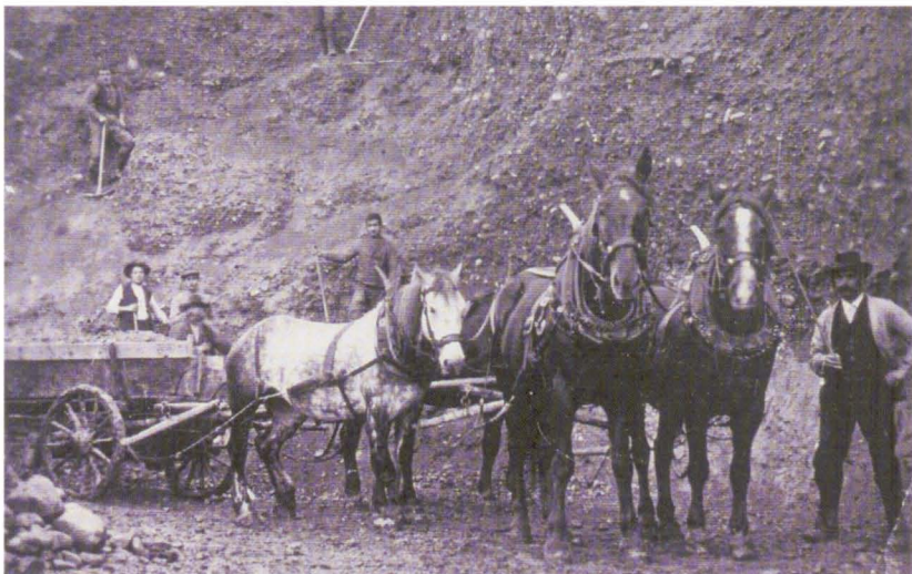
Kiesgrube in Gutenswil Pferdegefährt, Kies mit Pickel abgebaut und Schaufel beladen.
