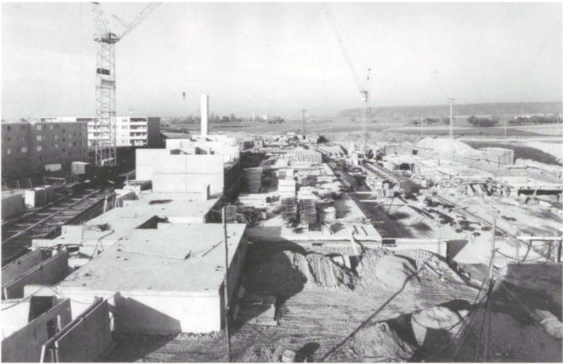
Die Firma Igéco AG sichert sich bei den Göhnerbauten den Anteil der Elementmontage für sich. (Bild: Pius Meyer)
