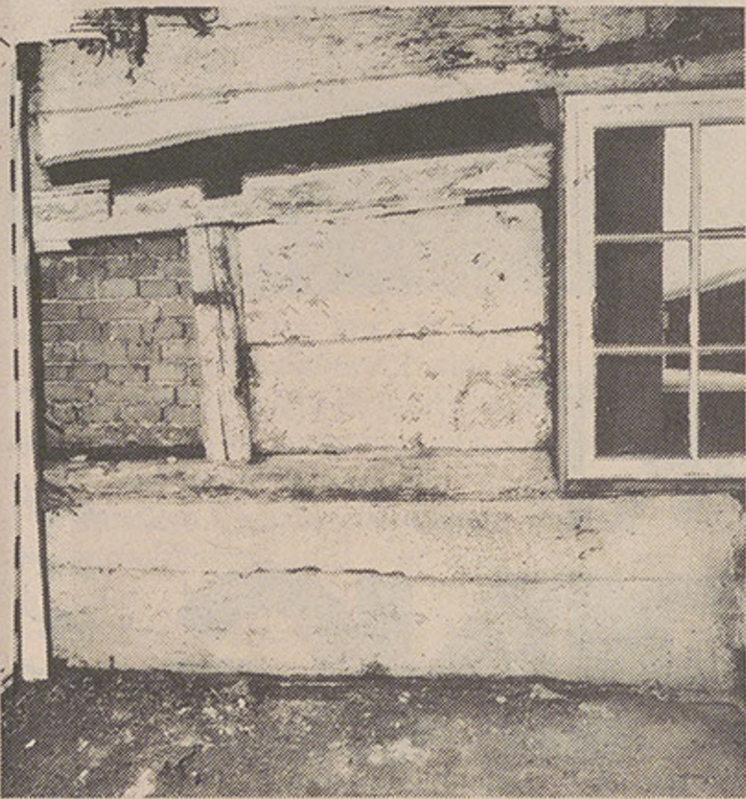
Bohlenwand – wahrscheinlich aus dem 16./17. Jahrhundert – mit Originalfenster (links, zugemauert).
