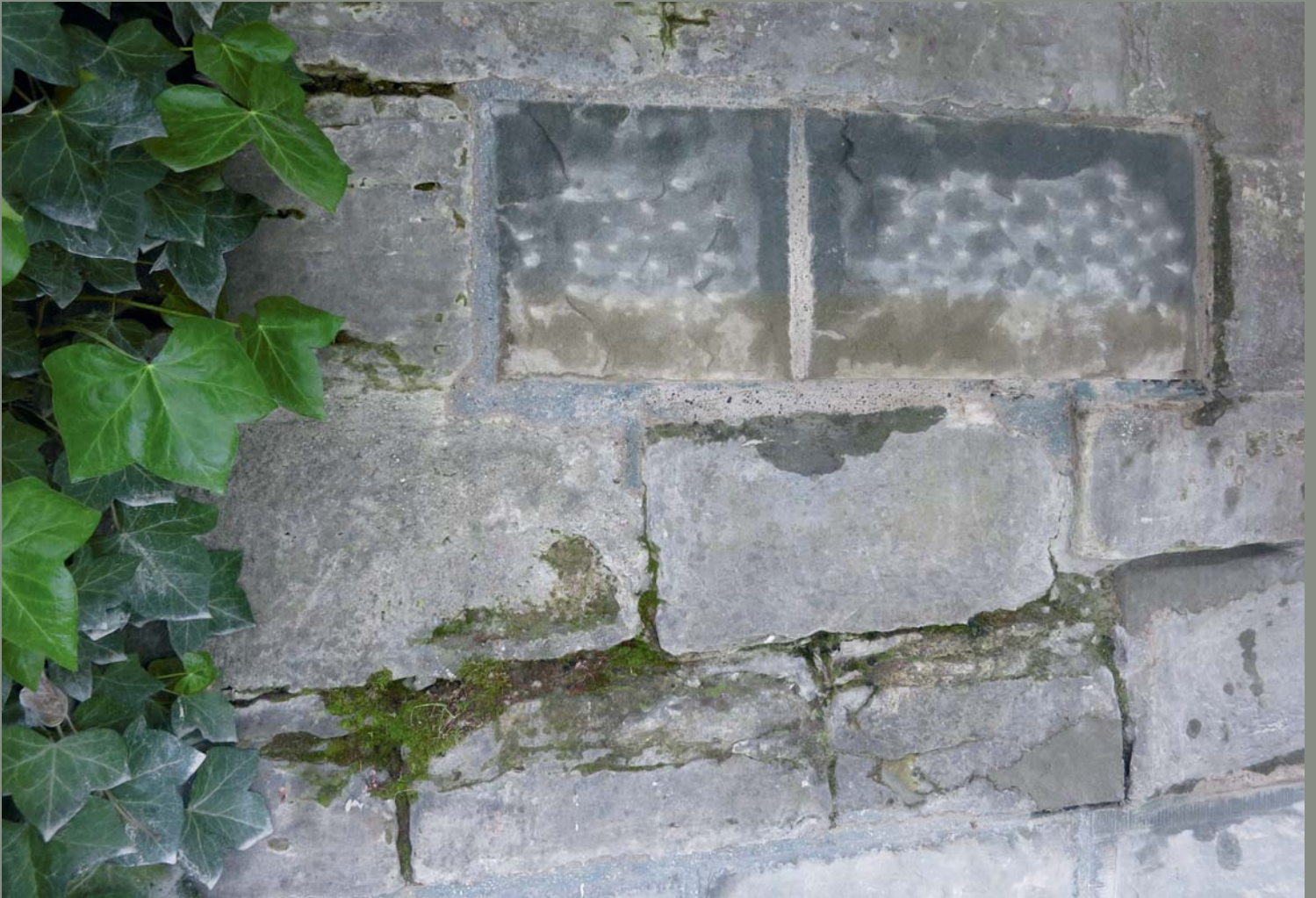
Vollersatz ganzer Werksteine der Schanzenmauer beim Zürcher Bollwerk zur Katz. Umschlag vorne: Stillgelegter Sandsteinbruch in Freienbach SZ.
