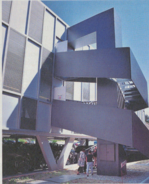
Der Neubau auf Stützen. Bild: Christoph Lehmann
