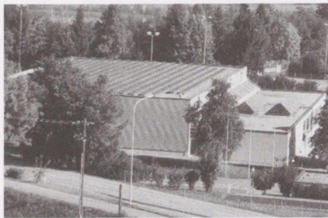
Beispiel eines nachhaltigen Projektes der Gemeinde Maur: Die Dreifachturnhalle mit der Photovoltaikanlage und Sonnenkollektoren.
