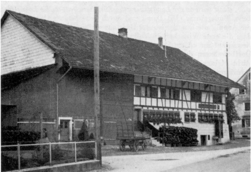
Im Teil rechts des stattlichen Doppelwohnhauses das Restaurant «Zur Alten Post», Zustand um ca. 1920. Bei einer vorhergehenden Renovation wurden die Riegelbalken entdeckt und wieder sichtbar gemacht.
