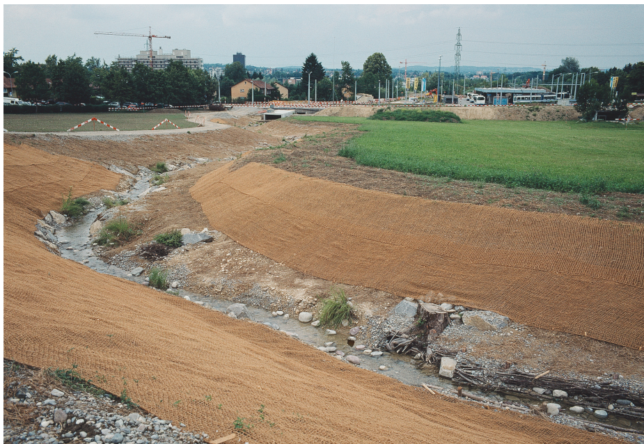
Der Bau der Glattalbahn erforderte die Verlegung des Sagentobelbachs. Seit 29. Juni 2009 fliesst der naturnah gestaltete Bach in seinem neuen Bett in Richtung Bahnhof Stettbach.
