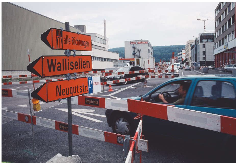
Geduldsprobe für Autofahrer: Zusammen mit dem Bau der Glattalbahn in der Ringstrasse wurden gleichzeitig alle Werkleitungen erneuert. Ringstrasse Anfang Juli 2009, Blick in Richtung Sonnental.
