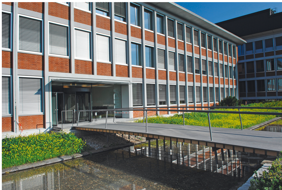
Die neue Brücke der EMPA besteht nur aus Holz und Kunststoff. Die einzigartige Konstruktion erhielt den Holzpreis Schweiz 2009.
